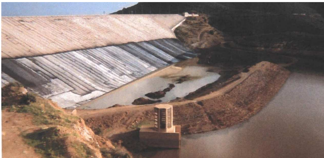
Figura 5.3.2: Avandiga durante la fase di costruzione
