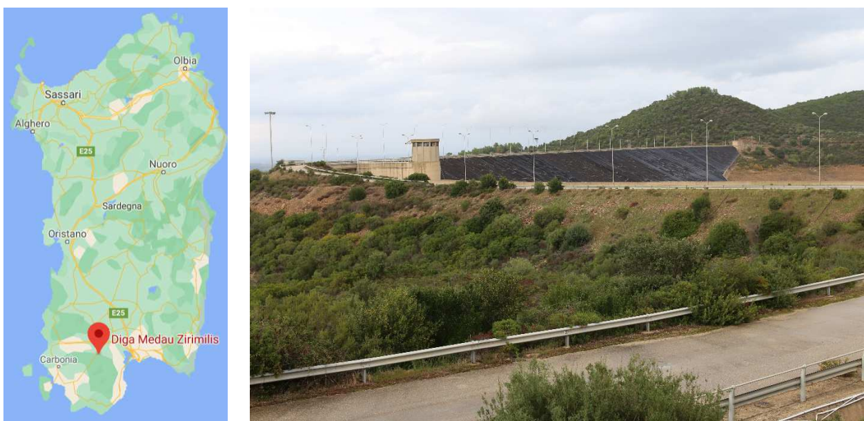
Figura 5.1.1: Localizzazione e ripresa fotografica dell'area interessata dagli interventi oggetto del presente Studio
