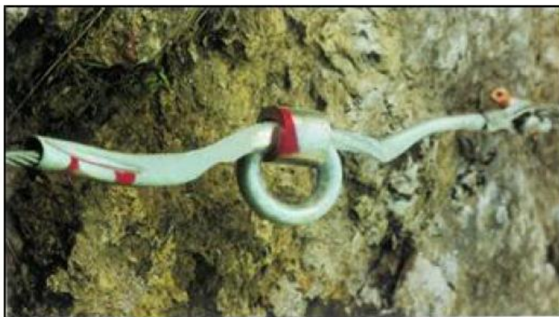
Figura 5.8: Particolare di un ancoraggio alla parete rocciosa
