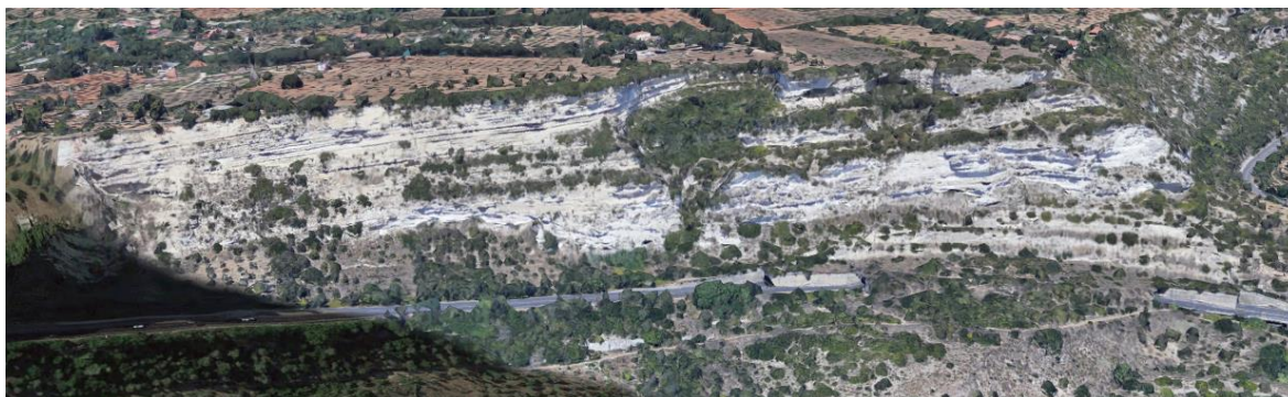
Figura 1.2: Panoramica del versante oggetto di intervento
