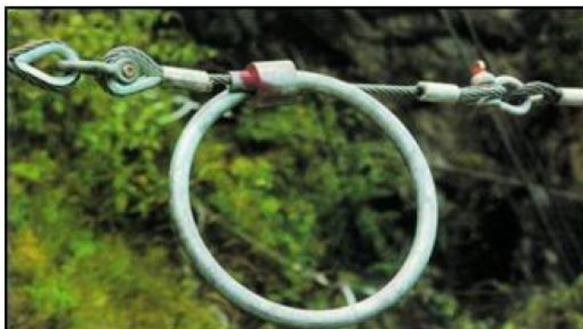
Figura 5.9: Particolare di dissipatore di energia ad anello
