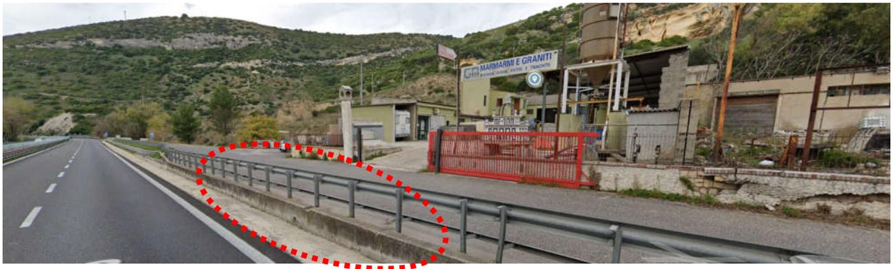
Ortofoto con indicazione del tratto di guard rail e relativo cordolo da rimuovere per garantire l'accesso di microfase allo Stabilimento
