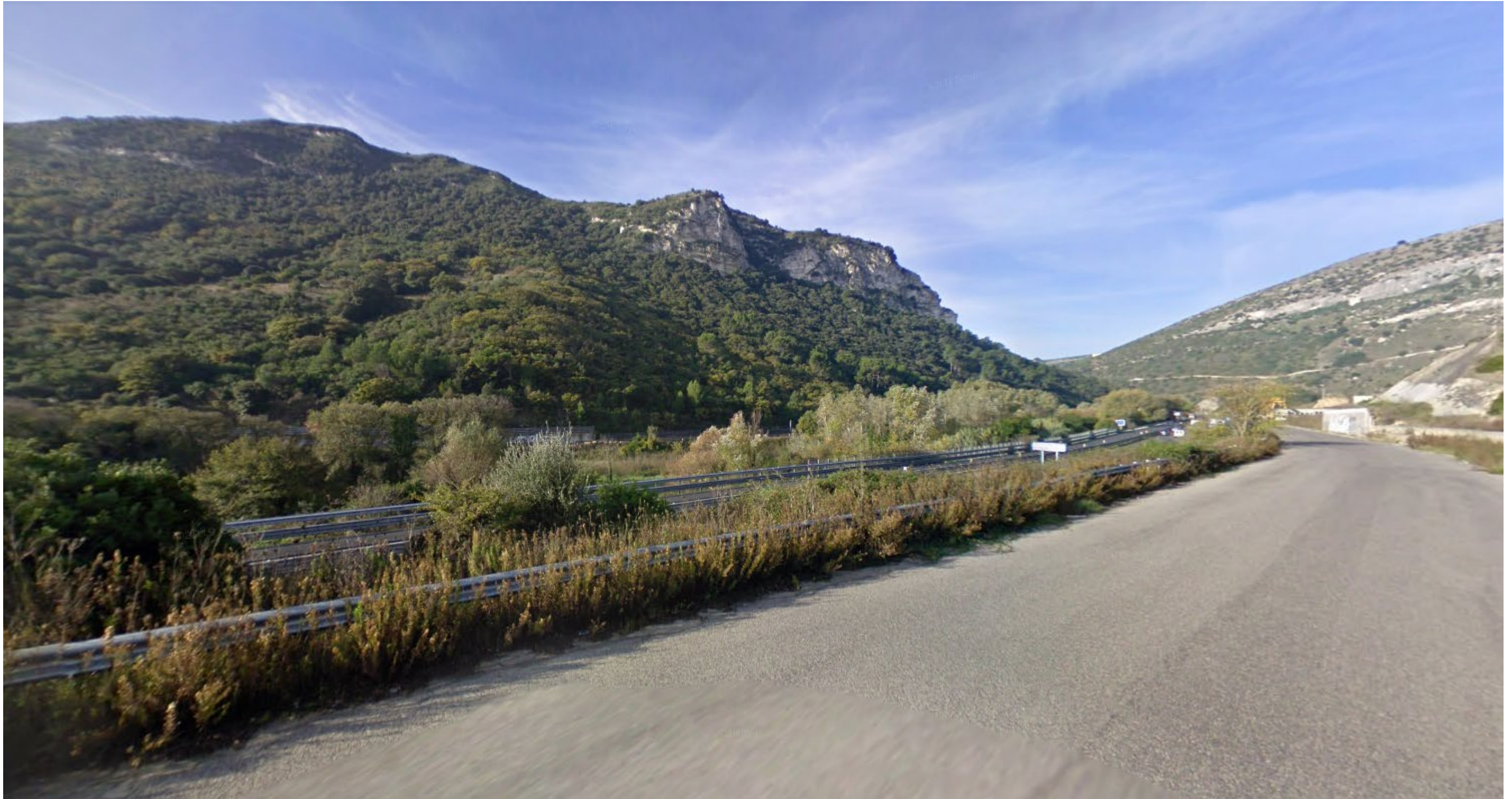
Punto 3: Progressiva 1+300.00: Vista da strada locale in direzione della statale SS131. Sia l'intervento che la presa fotografica ricadono nel vincolo articolo 142 del D.lgs. 42/2004 "Fiumi, torrenti e corsi d'acqua e relative sponde per una fascia di 150 metri" – co. 1, lett. c..Il corso d'acqua è il Riu Mascari che si sviluppa quasi parallelamente al tracciato attuale della statale fino al confine tra i comuni di Muros e Sassari. (Fonte: Google Earth)
