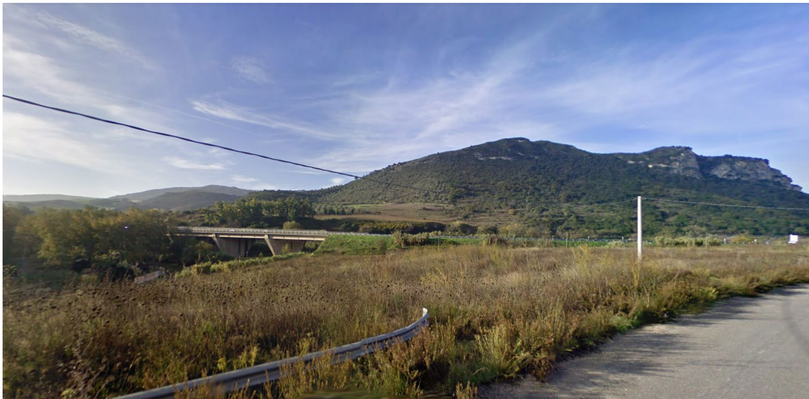
Punto 2: Progressiva 0+600.00. Vista da strada locale in direzione della statale SS131. Sia l'intervento che la presa fotografica ricadono nel vincolo articolo 142 del D.lgs. 42/2004 "Fiumi, torrenti e corsi d'acqua e relative sponde per una fascia di 150 metri" – co. 1, lett. c..Sulla sinistra è riconoscibile il viadotto che attraversa il Riu Mascari.(Fonte: Google Earth)
