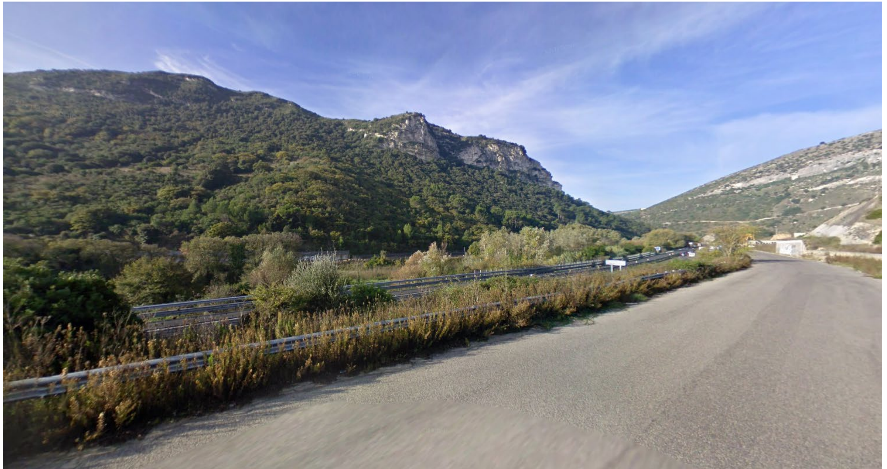
Punto 3: Progressiva 1+300.00: Vista da strada locale in direzione della statale SS131. Sia l'intervento che la presa fotografica ricadono nel vincolo articolo 142 del D.lgs. 42/2004 "Fiumi, torrenti e corsi d'acqua e relative sponde per una fascia di 150 metri" – co. 1, lett. c..Il corso d'acqua è il Riu Mascari che si sviluppa quasi parallelamente al tracciato attuale della statale fino al confine tra i comuni di Muros e Sassari. (Fonte: Google Earth)
