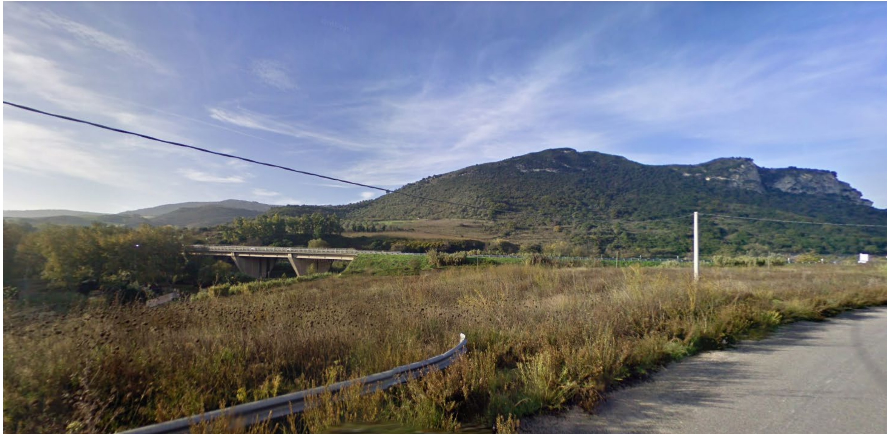
Punto 2: Progressiva 0+600.00. Vista da strada locale in direzione della statale SS131. Sia l'intervento che la presa fotografica ricadono nel vincolo articolo 142 del D.lgs. 42/2004 "Fiumi, torrenti e corsi d'acqua e relative sponde per una fascia di 150 metri" – co. 1, lett. c..Sulla sinistra è riconoscibile il viadotto che attraversa il Riu Mascari.(Fonte: Google Earth)
