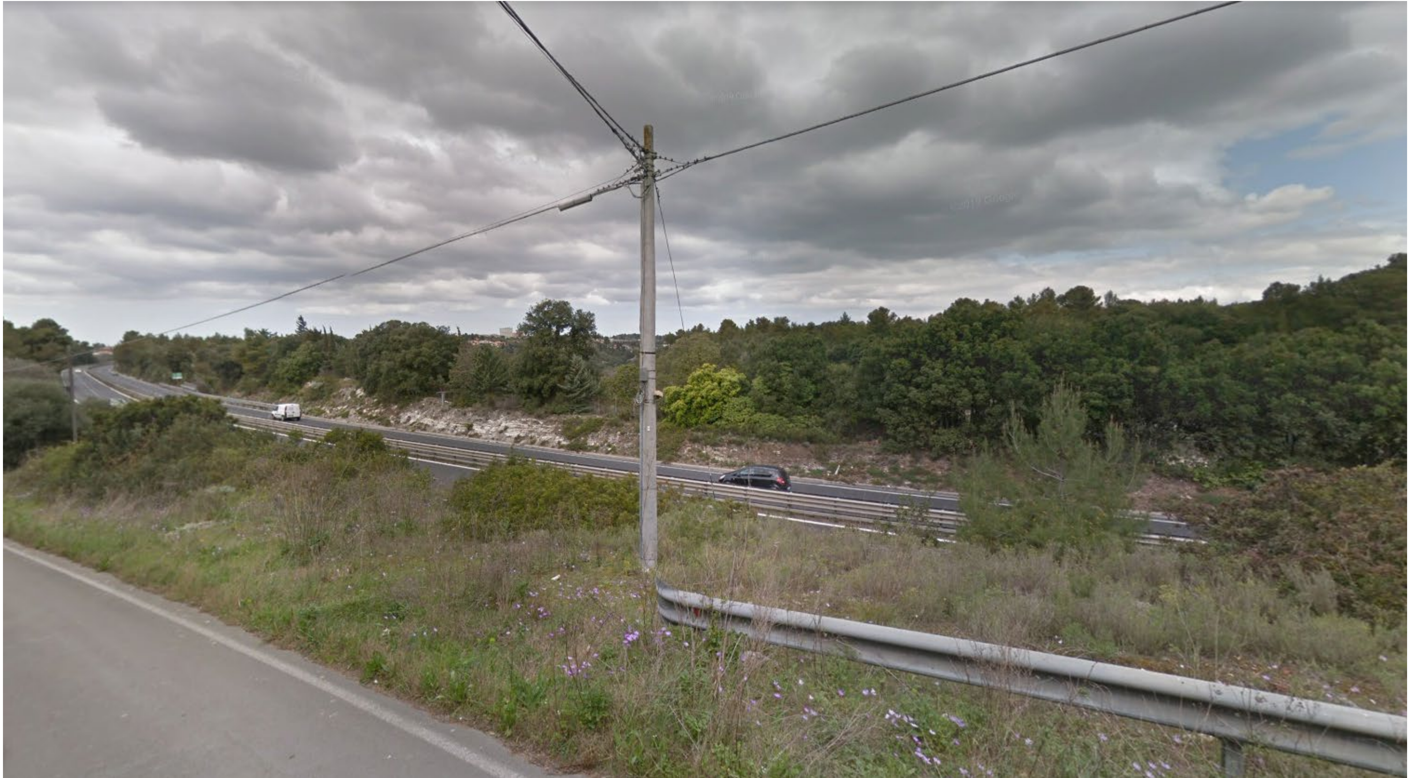
Punto 8: Progressiva 3+500.00: Vista da Str. Vicinale Rizzeddu Gioscari in direzione nord-ovest. Sia la presa fotografica che la strada statale SS131, ricadono nell'area "Terrazza a ovest della chiesa di San Pietro di Silchi sottoposta a vincolo "Aree dichiarate di notevole interesse pubblico" vincolata ai sensi dell'art.136 e 157 del D.lgs. 42/2004 La porzione di statale visibile nella foto è il tratto compreso tra l'uscita dalla galleria e l'area corrispondente a Tingari, collocata dopo la curva. L'ambito si caratterizza per la forte presenza di vegetazione, tipica nella cintura periurbana di Sassari. (Fonte: Google Earth)
