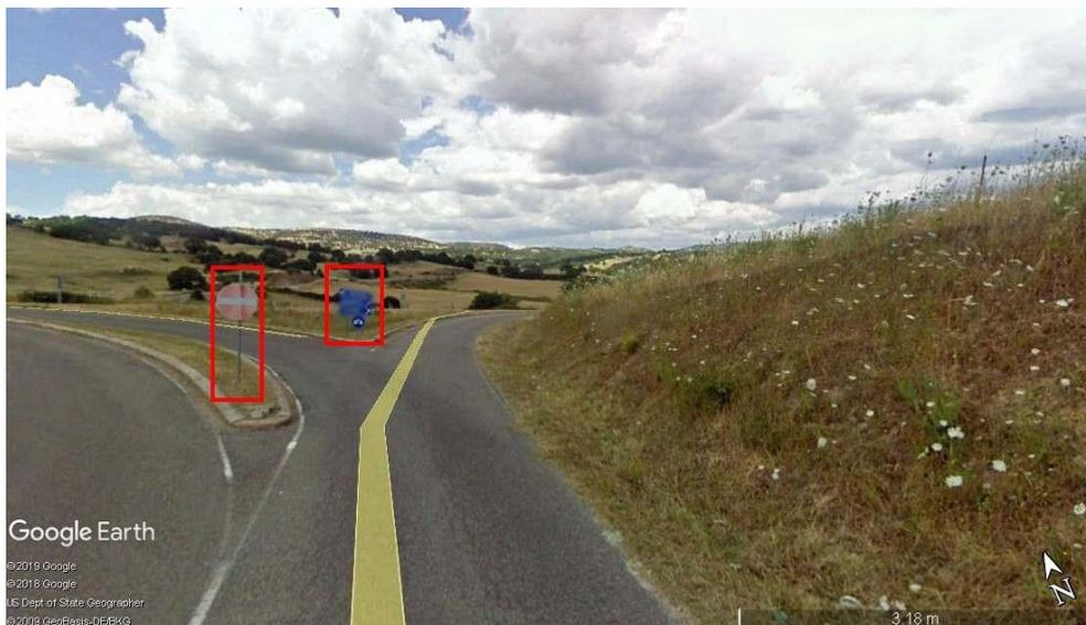
Modificazione delle isole di traffico e compattazione della larghezza di 8 m, rimozione dei cartelli, taglio dei rami
