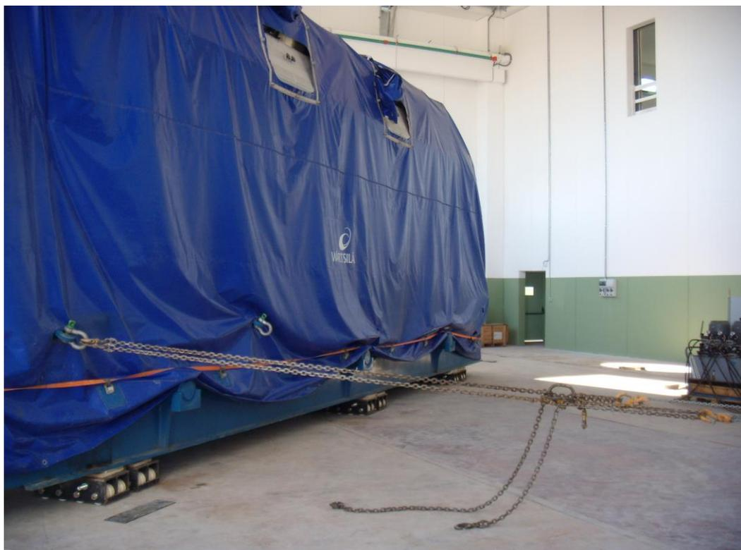
Figura 10 – Foto di repertorio 2 – Rotazione motore con “carriarmati”
