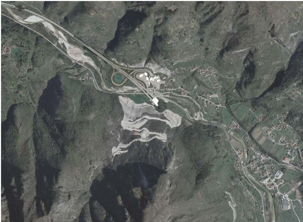
Figura 66: Vista dell'alto dello svincolo Valle dell'Astico Km 18+600
