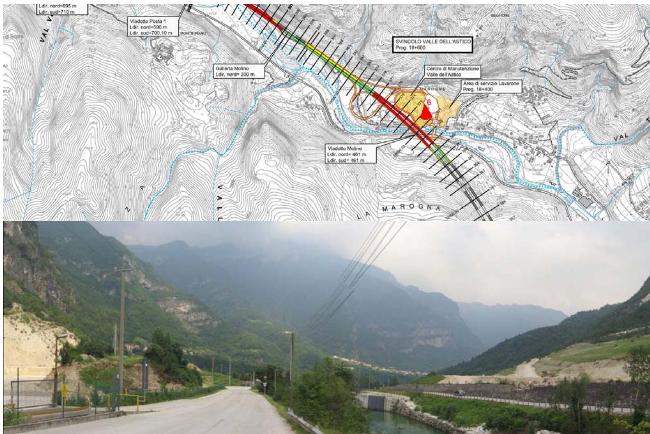
Figura 41: Panoramica in prossimità del viadotto Molino e dello Svincolo Valle dell'Astico
