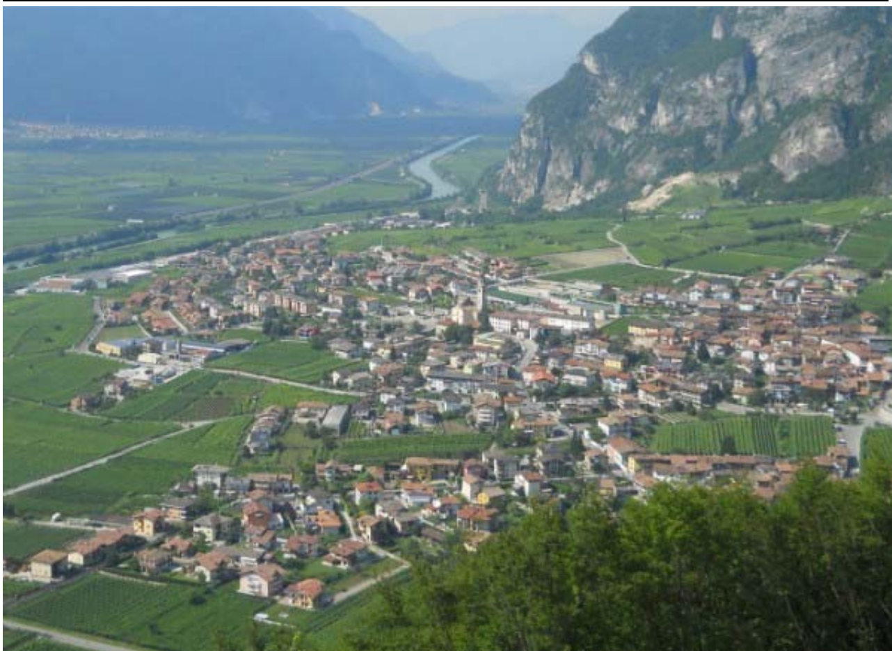
Figura 1: Esempio di ambito edificato: centri urbano di Besenello in valle dell'Adige
