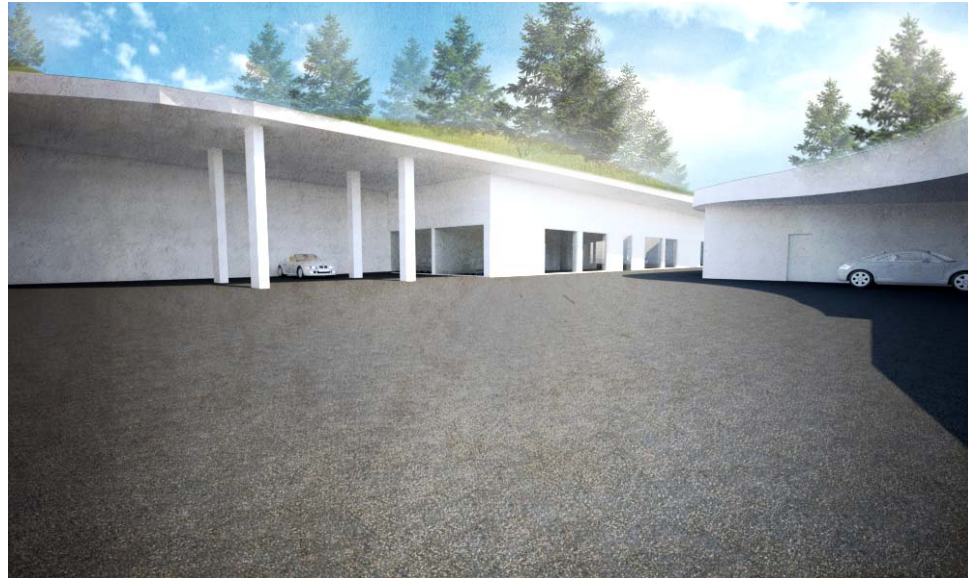
Figura 38: Edifici centro di manutenzione Besenello
