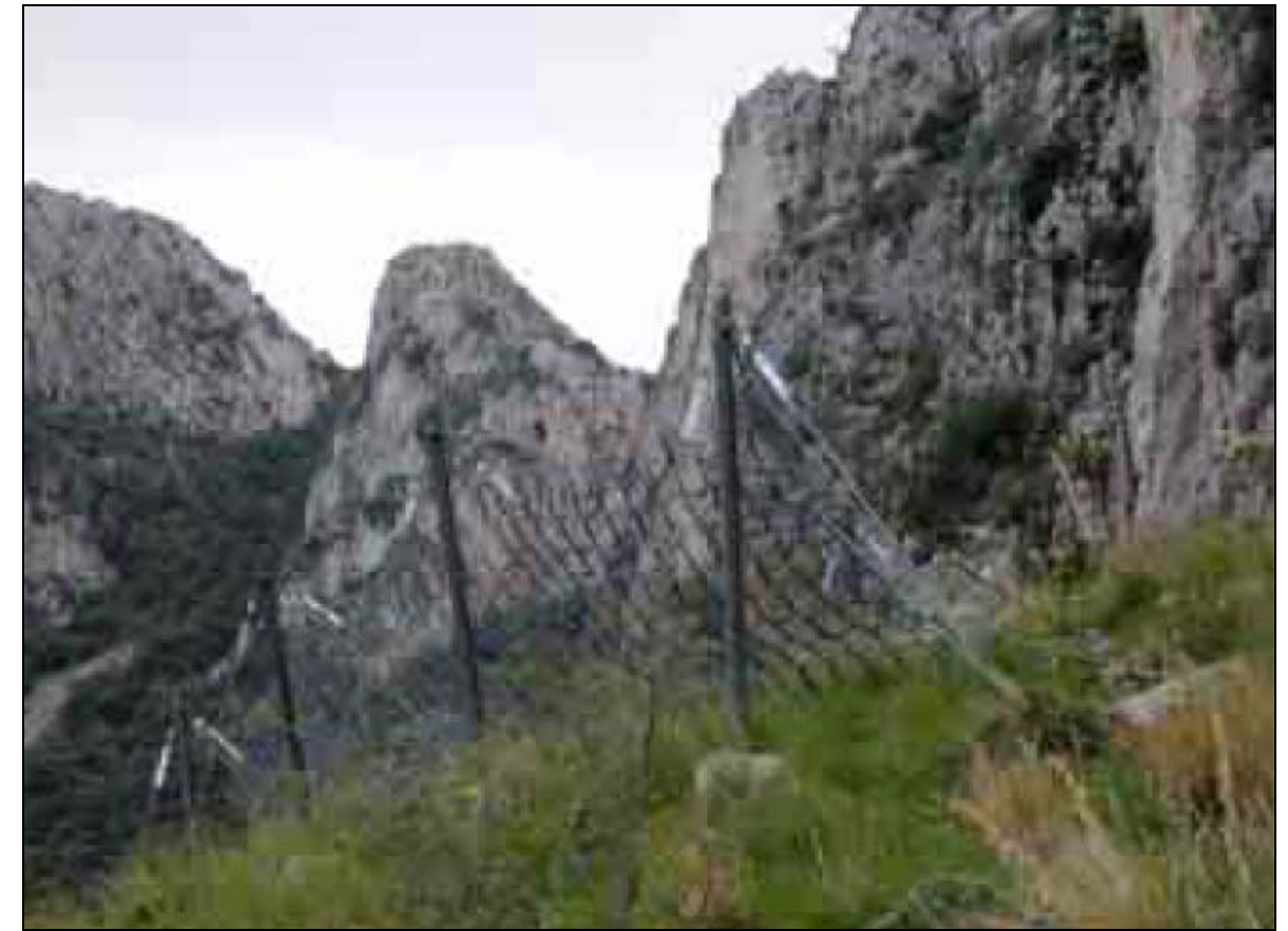
Figura 53: Barriera paramassi elastica ad alto assorbimento di energia tradizionale.
