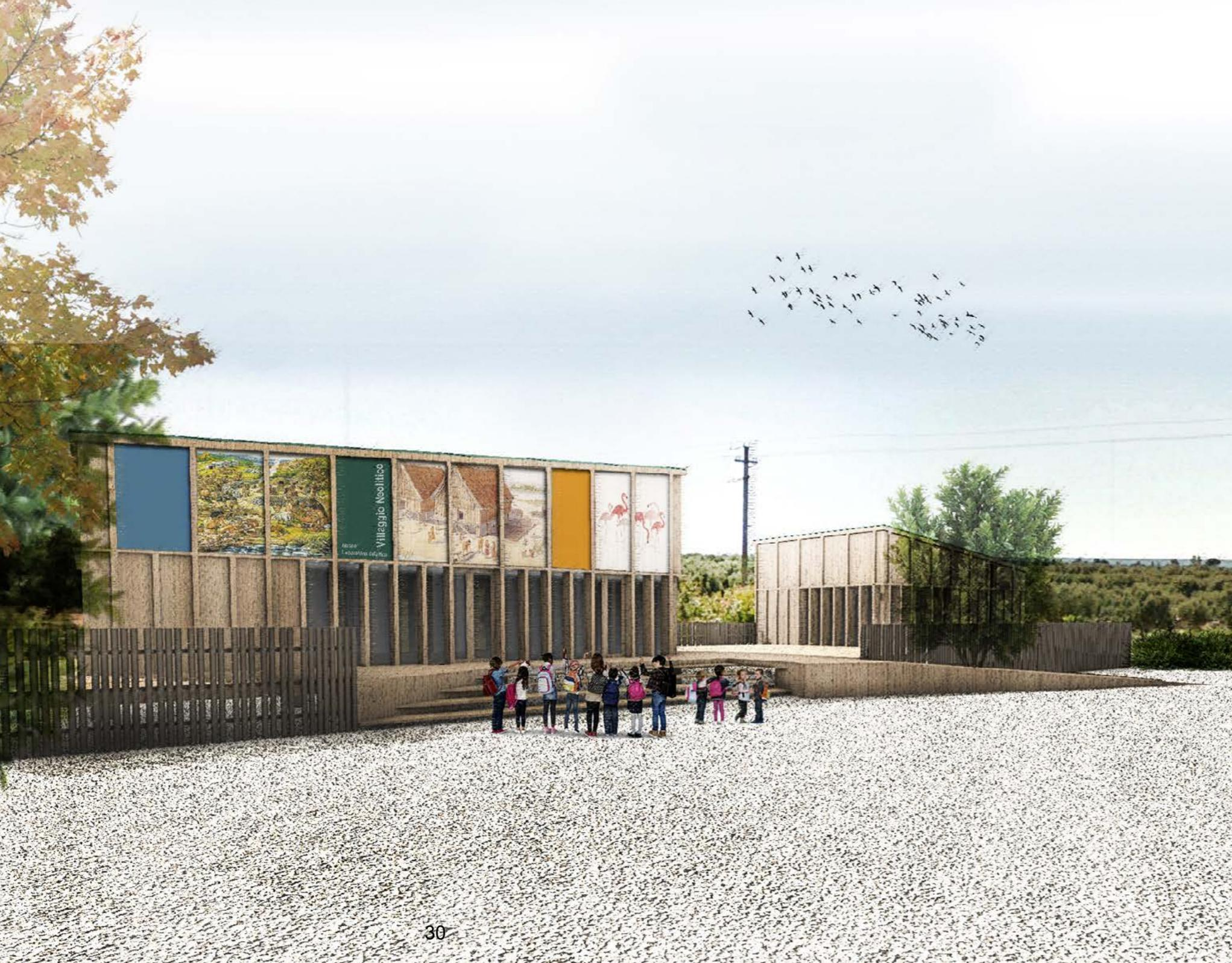
L'architettura del blocco servizi sarà realizzata logiche di sostenibilità ambientali e avrà pertanto una struttura in legno del tipo a telaio con sistema a secco. Questo permetterà di avere un impatto minimo sull'ambiente, la reversibilità dell'intervento oltre all'utilizzo di materiali riciclabili.
