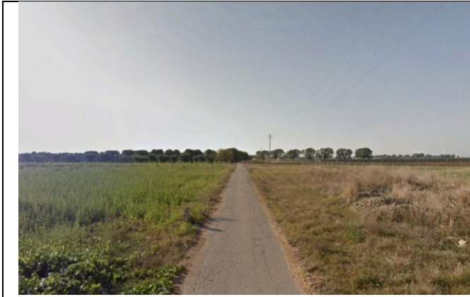
Foto 25 - S.C. a ovest SPV07 – Direzione sud
