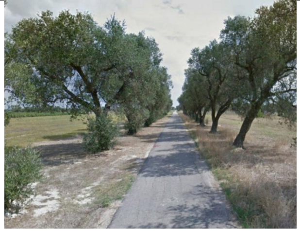
Foto 38 - S.C. a nord SPV10 – Direzione est
