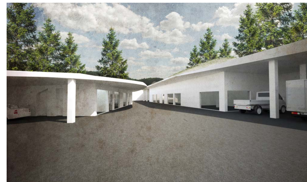
Figura 34: Edifici centro di manutenzione Besenello
