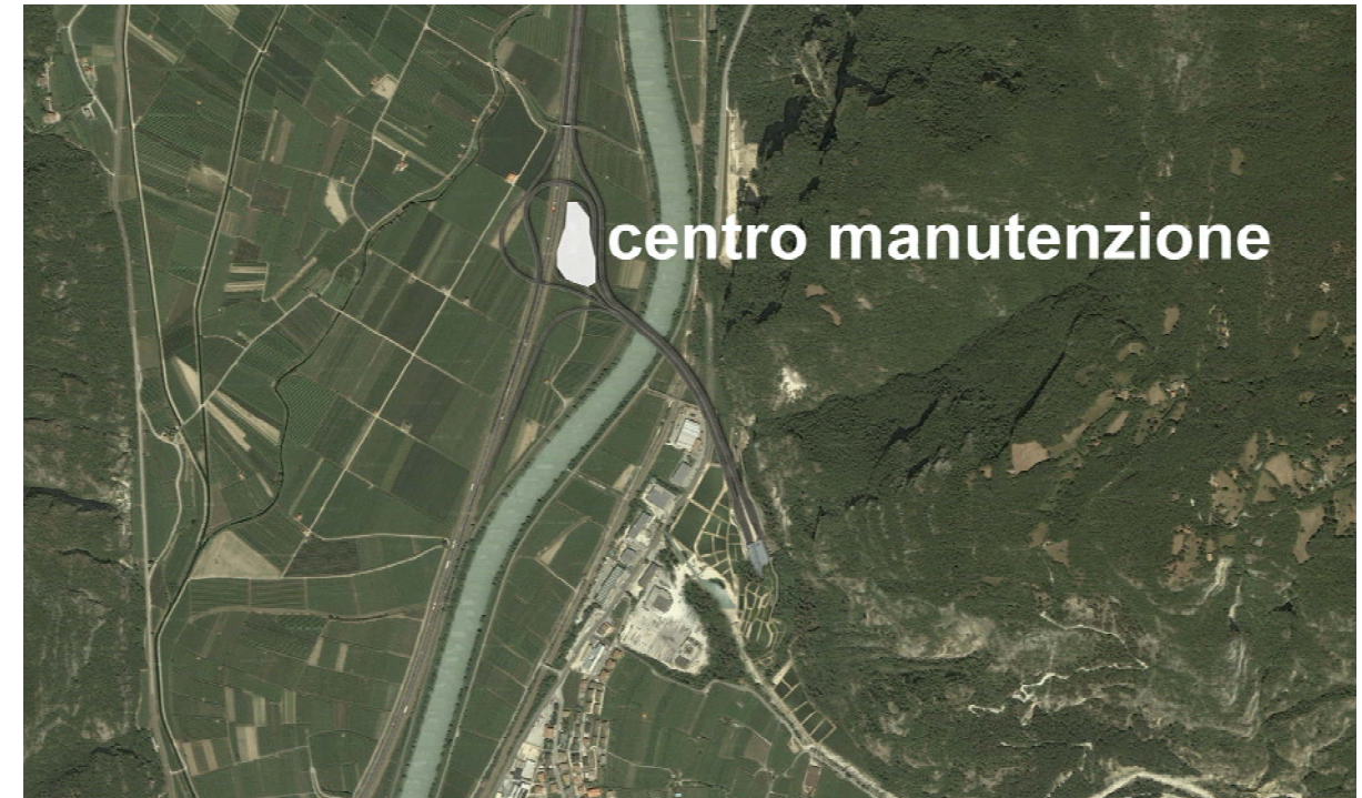
Figura 31: Vista dall'alto dell'interconnessione con l'A22 e dell'ubicazione del centro di manutenzione
