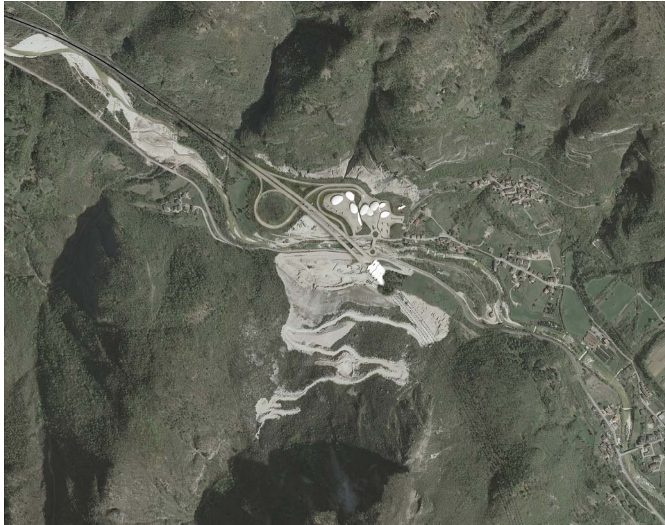
Figura 27: Vista dell'alto dello Svincolo Valle dell'Astico
