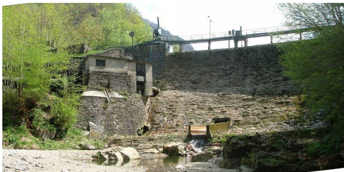
Fig. 5 Diga da valle, con fabbricato valvole di intercettazione della derivazione e sbocco dello scarico di fondo. – maggio 2006
