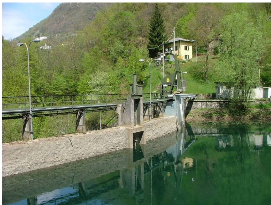
Fig. 4 Diga da monte con scarico di fondo, sgrigliatore e casa di guardia. maggio 2006
