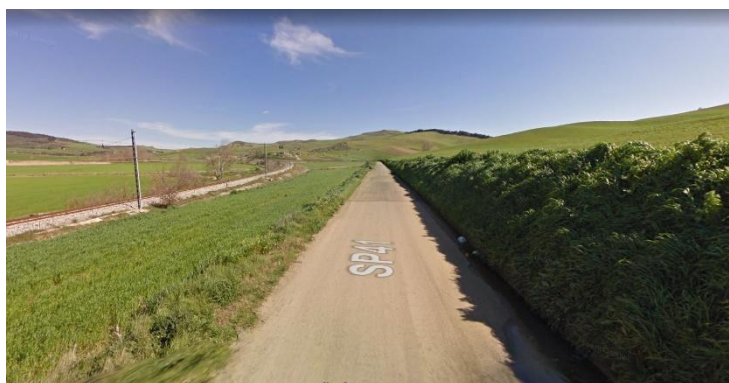
Figura 1: Vista della SP 41 esistente in affiancamento alla linea ferroviaria
