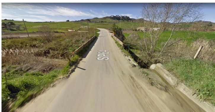
Figura 1: Vista della SP 64 esistente in approccio al sovrappasso della ferrovia
