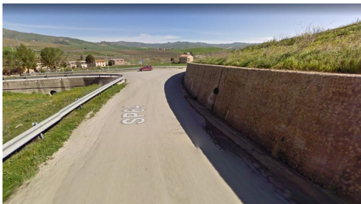
Figura 1: Vista della SP 64 esistente in approccio all'intersezione a raso con la viabilità di collegamento con la stazione di Vallelunga
