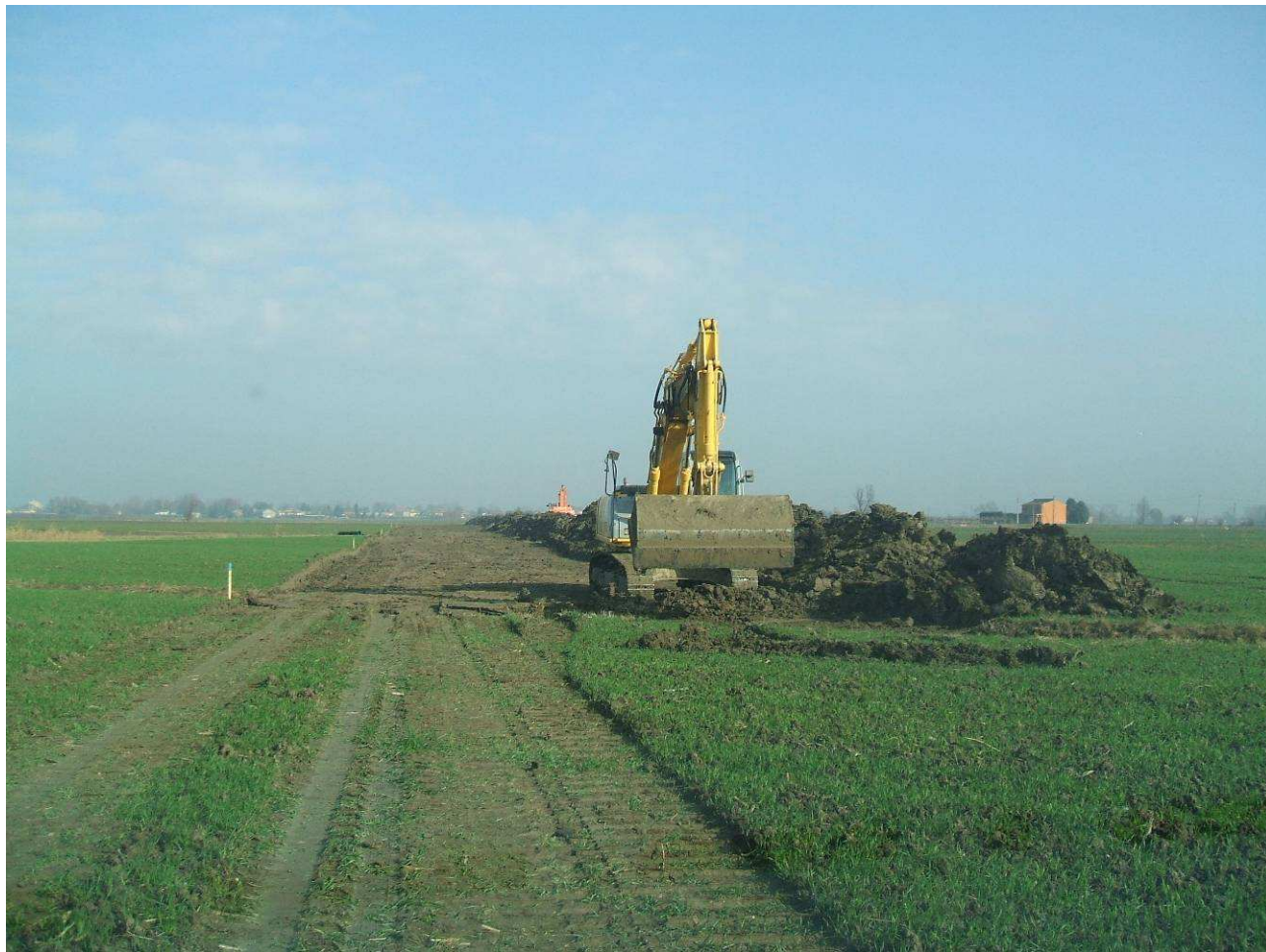
Fig. 2.1 - Accantonamento dello strato humico superficiale durante lo scotico dell'area di passaggio.
