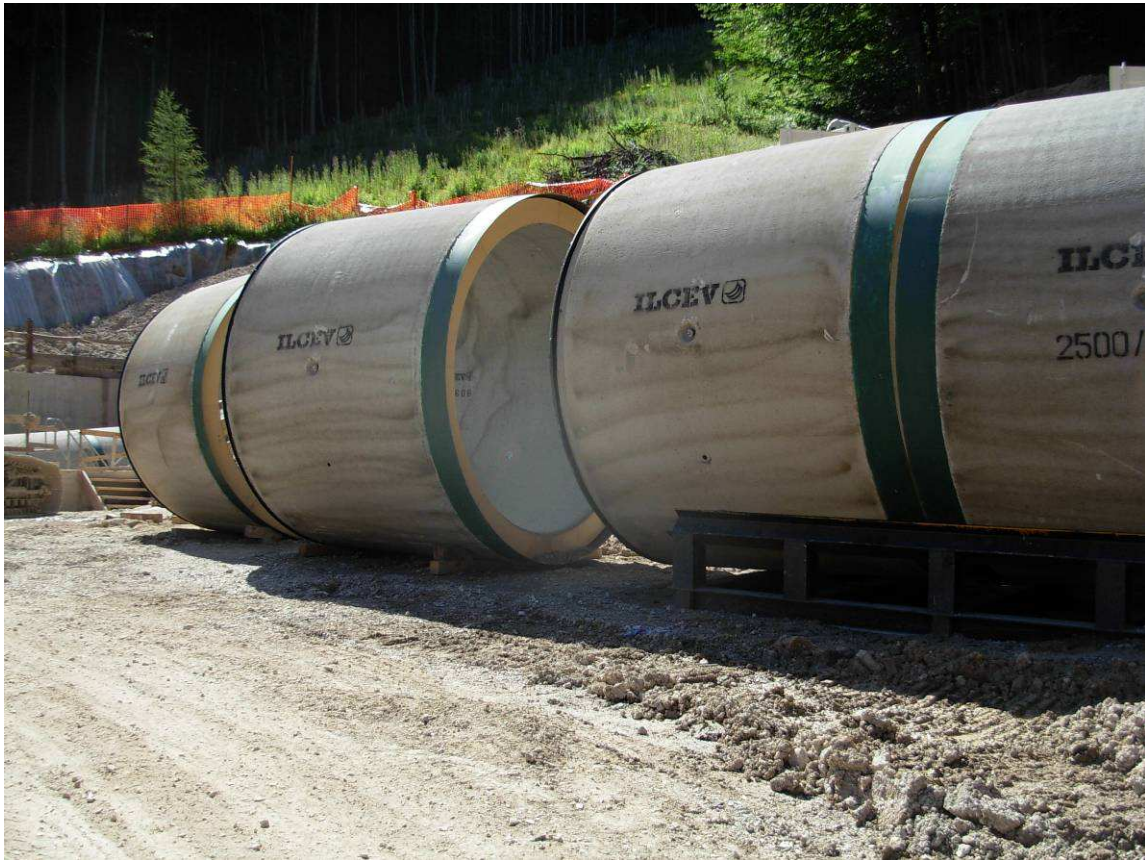
Fig. 2.7 - Stoccaggio tubi in c.a.
