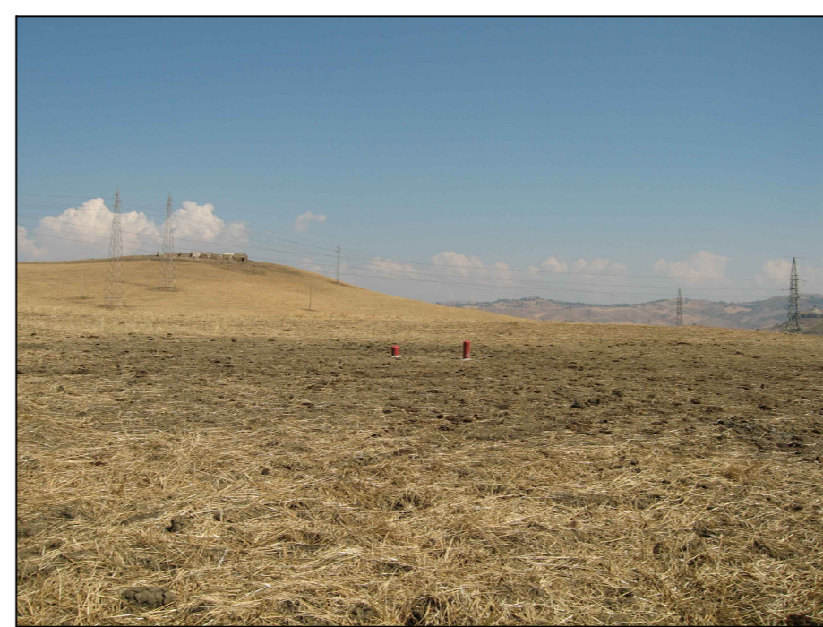
AREA DELL'IMBOCCO VISTA DA SUD. AL CENTRO DELLA FOTO I SONDAGGI 3B-F03/F03a
