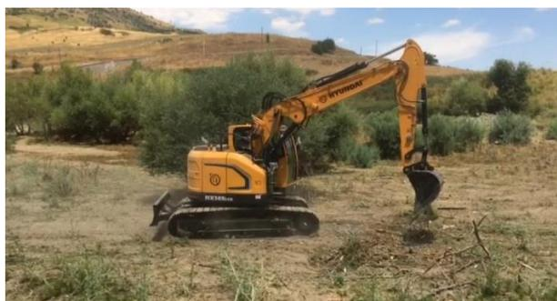
**Foto 1:** fase di realizzazione di una pista di accesso per consentire il raggiungimento della piazzola di lavoro del sondaggio 3a S26
