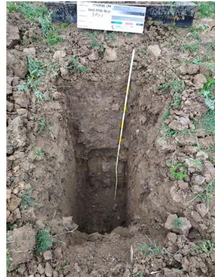
**Foto 8:** A sinistra, fase di scavo del pozzetto geognostico; a destra, foto dello scavo realizzato.
