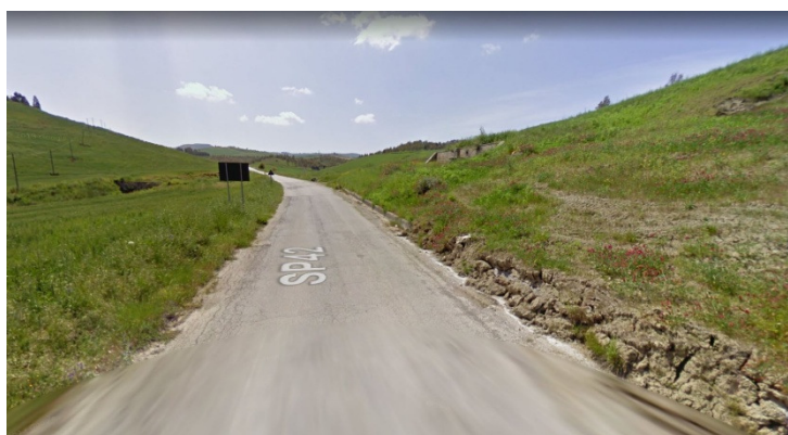
Figura 1: Vista della SP 42 esistente nel tratto d'intervento
