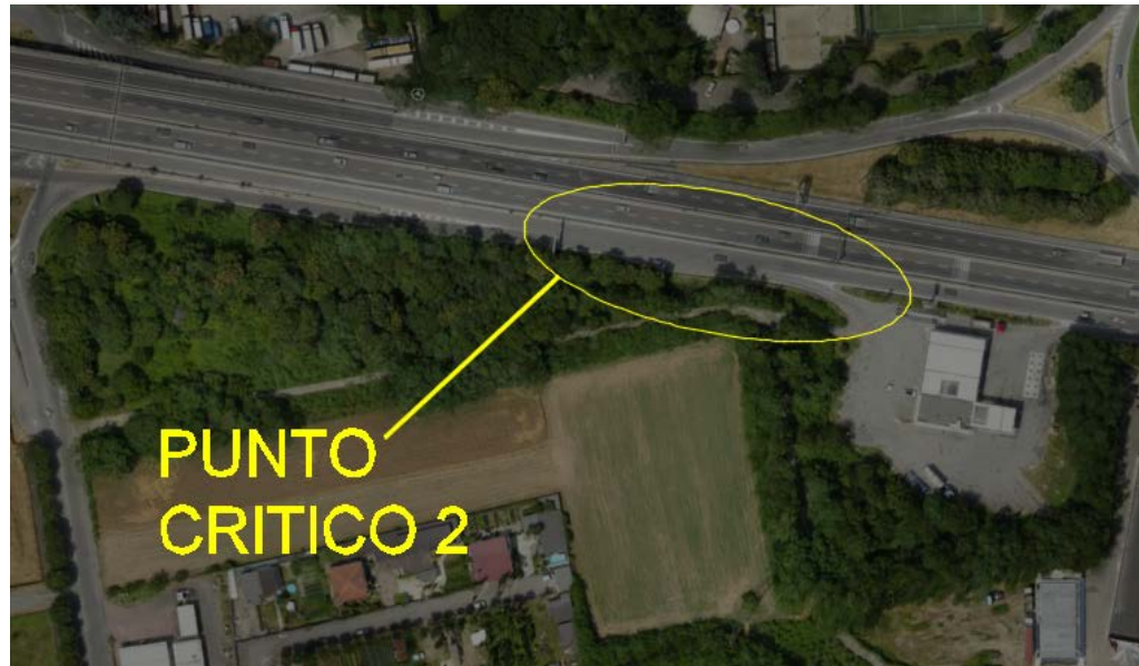
Figura 18 - Dettaglio punto di conflitto 2
