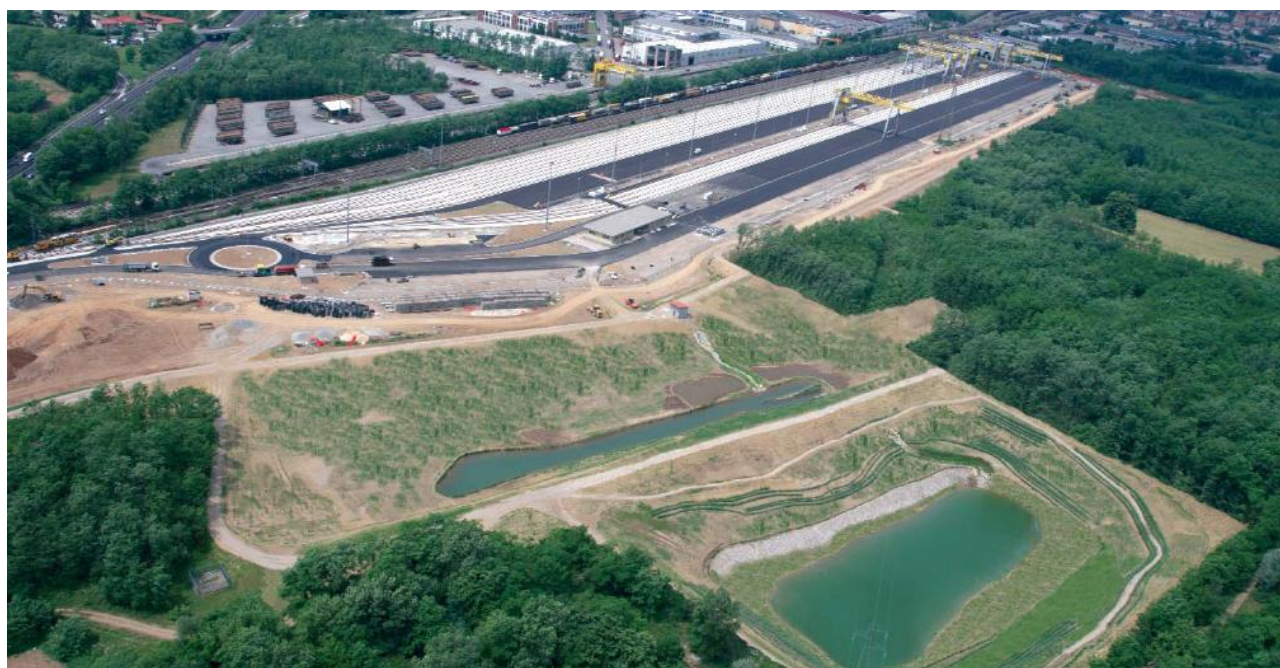
Ulteriore vista della fase realizzativa : fonte HUPAC
