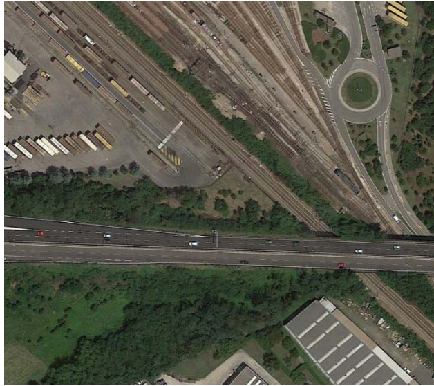
Cantiere operativo CO03
