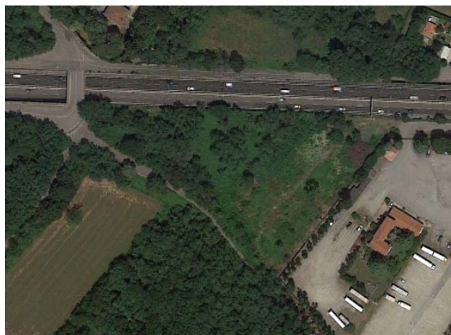
Area cantiere operativo CO02
