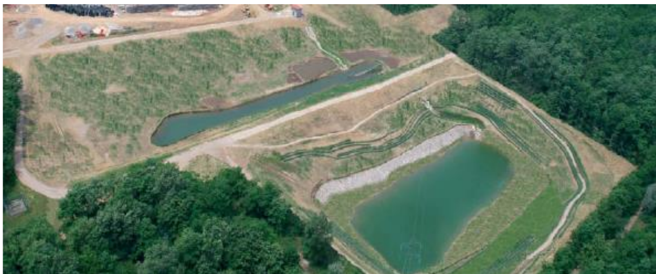
Fig.6 - Immagine aerea delle vasche di spagliamento dei torrenti Rile e Tenore.
