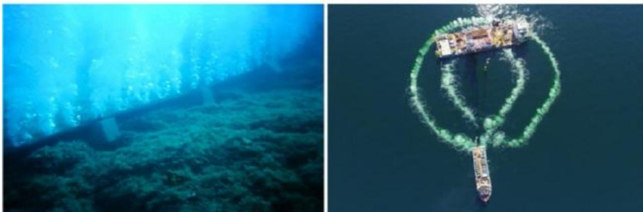
Figura 3-6 Zone con cortina di bolle rilasciata da un tubo perforato poggiato sul fondo (sinistra) e doppia cortina di bolle utilizzata intorno ad una imbarcazione (a destra) (fonte: © hydrotechnik lübeck gmbh)
