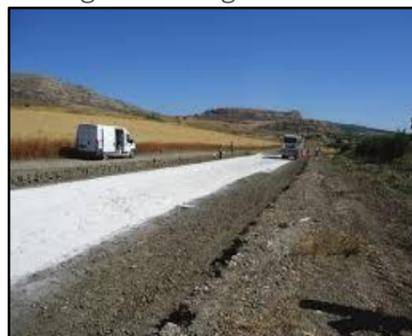
tramite mezzo specifico, viene distribuita la calce in quantità tale da garantire il previsto rapporto (%) terreno/calce preventivamente definito in laboratorio. Se necessario, a secondo del valore di umidità nel terreno
