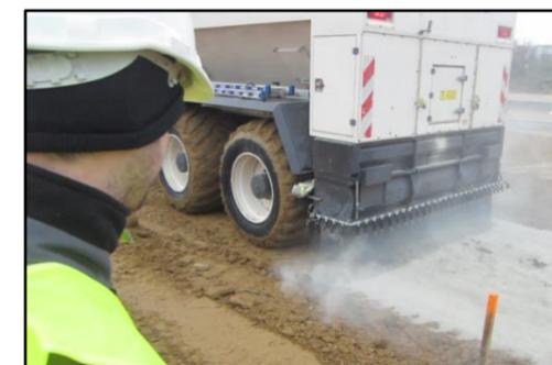
determinato tramite le previste analisi di verifica quotidiana, si procede alla bagnatura. La miscelazione terreno/calce si realizza tramite apposita macchina che provvede, durante il suo avanzamento, a miscelare e regolarizzare il terreno. Chiude il processo il rullo compattatore che, in base alle risultanze della prova Proctor, provvede alla compattazione del terreno.
