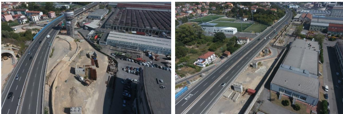
Figura 4.16 – Viadotto VI12 Rampa N – Documentazione fotografica
