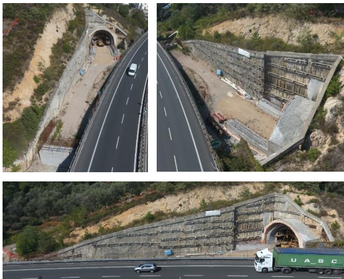
Figura 4.7 – Galleria Naturale Fornaci III – Paratie di imbocco Sud
