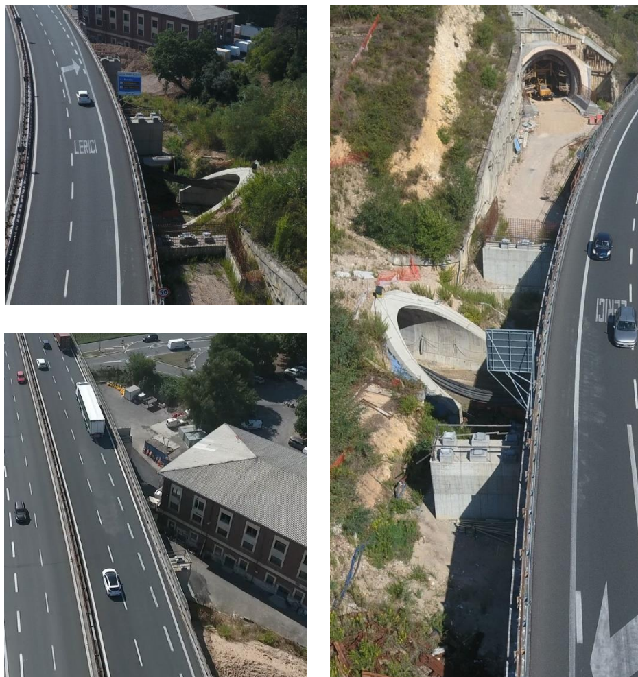
Figura 4.19 – Viadotto VI15 Rampa W – Documentazione fotografica
