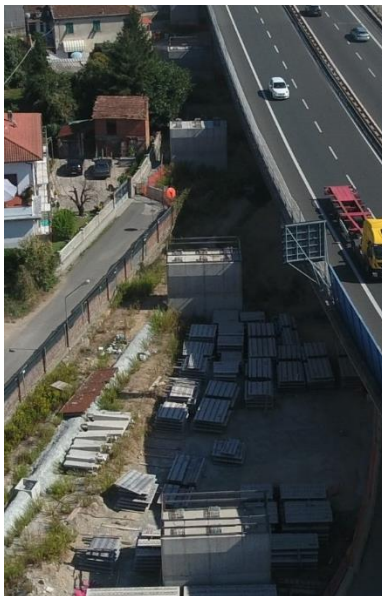
Figura 4.18 – Viadotto VI14 Rampa S – Documentazione fotografica
