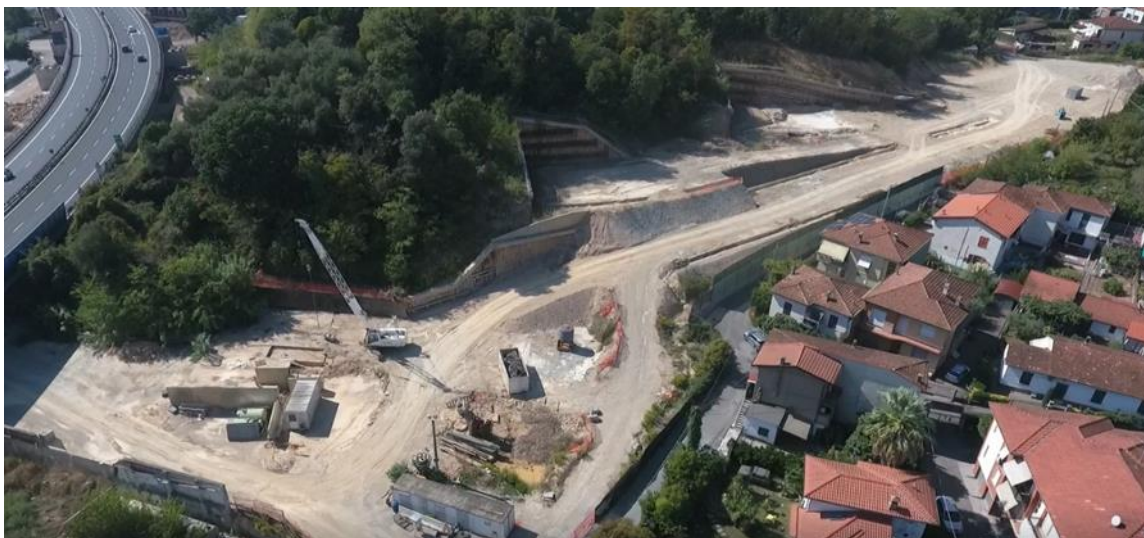
Figura 4.12 – Galleria artificiale Felettino II
