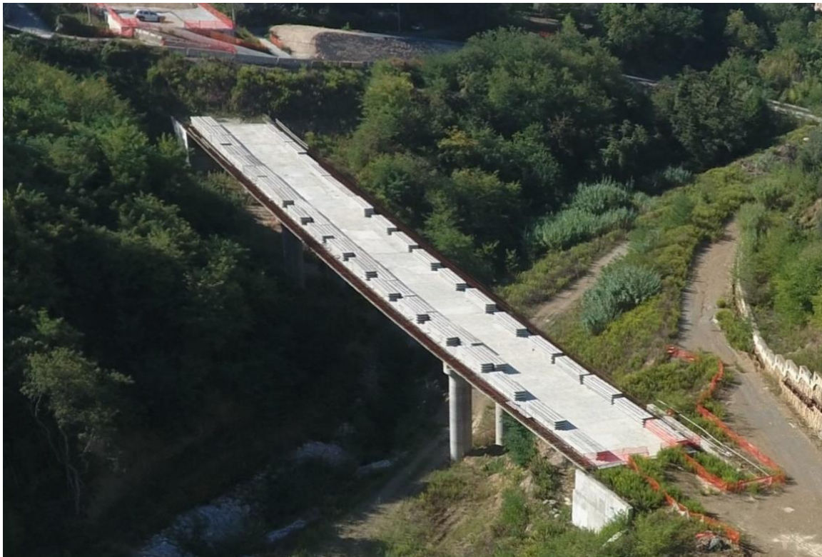
Figura 4.14 – Viadotto San Venerio II – stato avanzamento lavori
