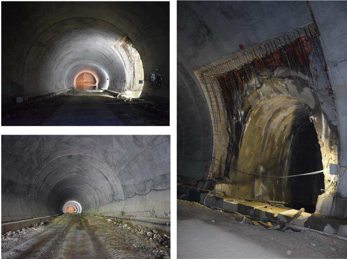
Figura 4.5 – Galleria Naturale Fornaci I – Stato realizzativo interno
