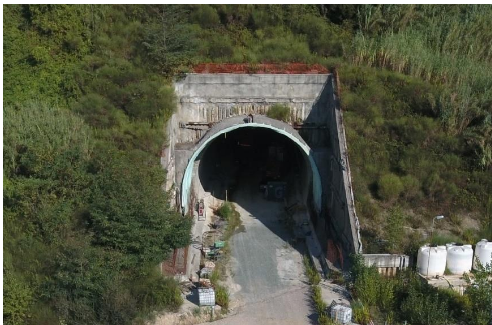
Figura 4.3 – Galleria Naturale Felettino III – Stato realizzativo imbocco Sud
