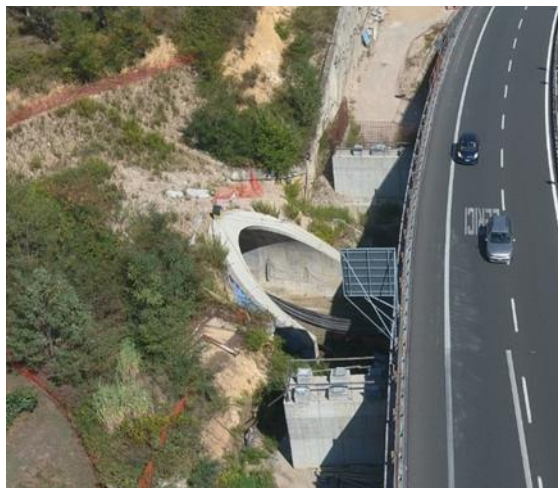
Figura 4.9 – Galleria Naturale Fornaci IV – Imbocco Sud
