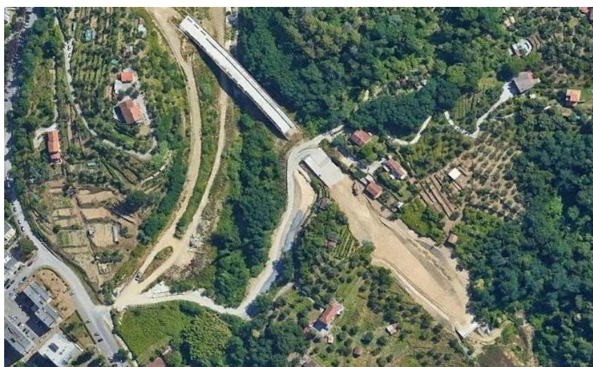
Figura 4.11 – Galleria artificiale Felettino II
