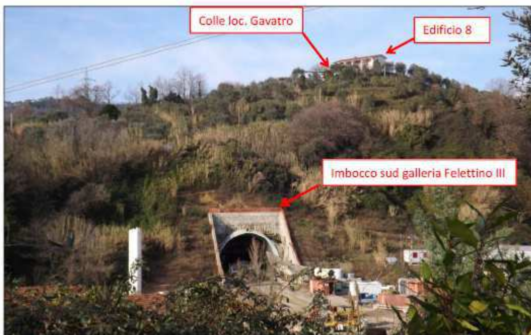
Figura 5 Galleria Naturale Felettino III – Versante sud con indicazione della posizione dell'edificio 8
