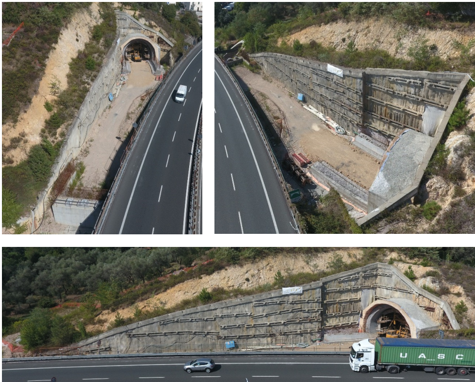
Figura 3 – Galleria Naturale Fornaci III – Paratie di imbocco Sud
