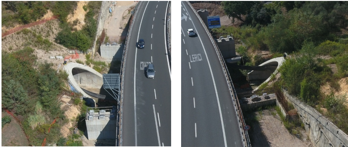
Figura 2 – Galleria Naturale Fornaci IV – Imbocco Sud - Vista a fine cantiere da drone
