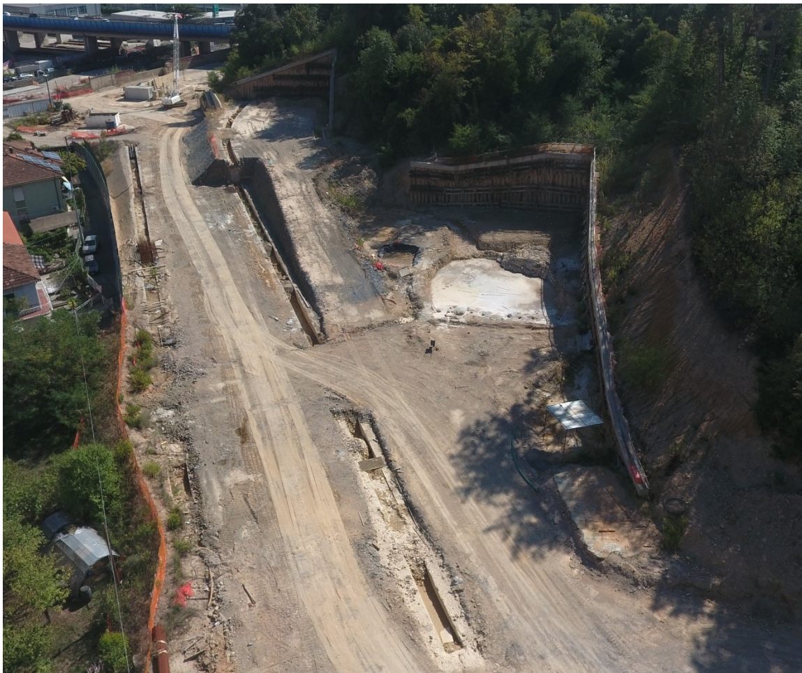
Figura 5 – Galleria artificiale Fornaci II – Vista a fine cantiere da drone
