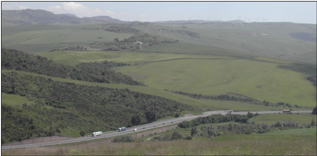
Foto 3: Rocchetta Sant'Antonio. Zona di attraversamento dell'autostrada
