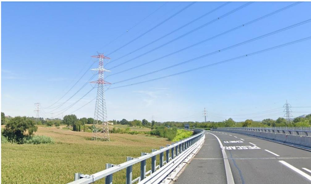
**Figura 3-6 Sostegno elettrodotto oggetto di intervento, con la colorazione bianco-rossa del terzo superiore. Visuale dallo svincolo autostradale Chieti-Pescara**
