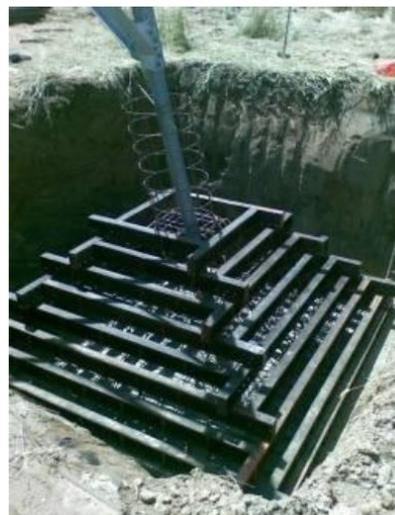
**Figura 3-19 Esempio di realizzazione di una fondazione a pinto con riseghe. Nell'immagine di sinistra di può osservare un disegno di progetto mentre nell'immagine di destra la fase di cassetatura della fondazione**
