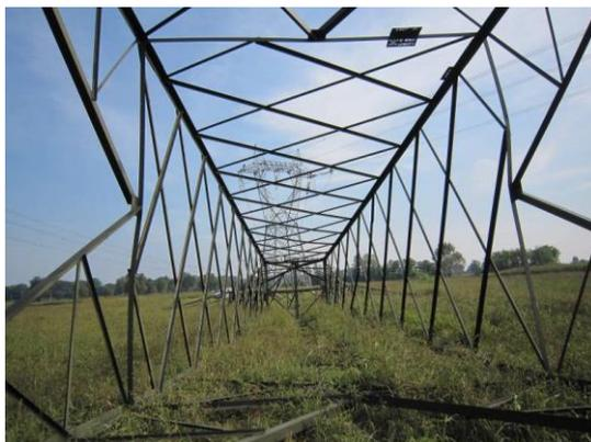
**Figura 3-9: Fasi demolizione di un sostegno a traliccio**
