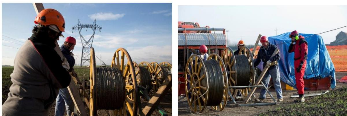
**Figura 3-27 Fasi di tesatura della linea elettrica**
