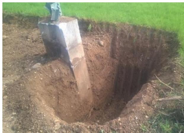
**Figura 3-11: - Esempio di rimozione fondazione superficiale di un sostegno 220 kV (a sx) e 380 kV ST (a dx).**
