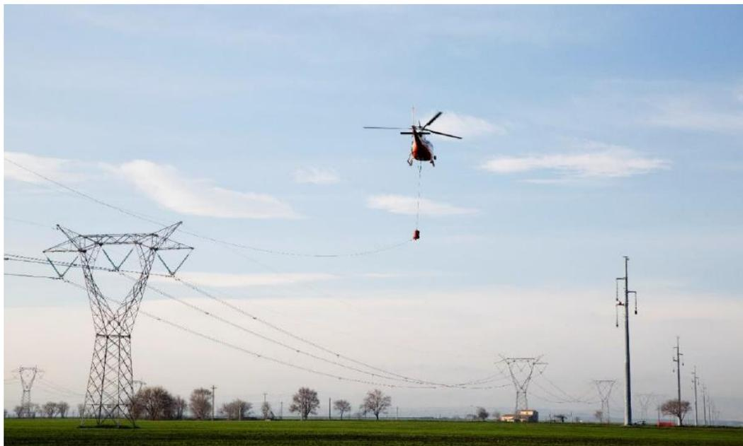
**Figura 3-26 utilizzo dell'elicottero per la stesura della fune pilota**
