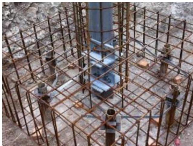
**Figura 3-24 Esempio di realizzazione di una fondazione su micropali tipo tubfix**
