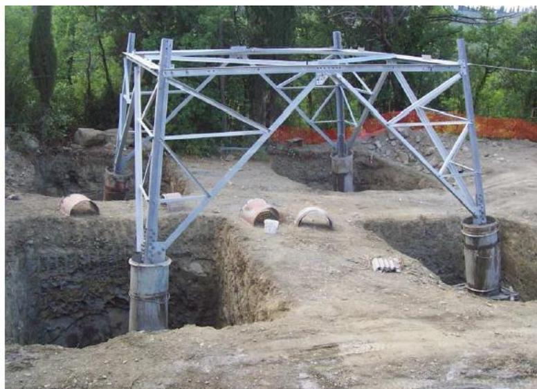
**Figura 3-20 Realizzazione di fondazioni superficiali tipo CR per un sostegno a traliccio, con le quattro buche, la base del sostegno collegata alla fondazione tramite monconi ed i casseri utilizzati per i quattro colonnini**
