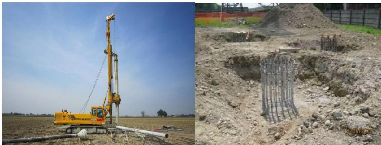
**Figura 3-22 Macchina operatrice per la realizzazione di pali trivellati**
