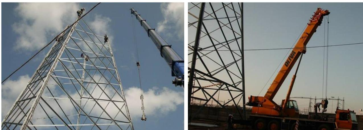
**Figura 3-25 - Fasi di montaggio sostegno a traliccio**
