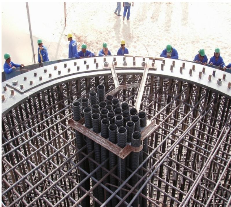
La copertura in calcestruzzo delle armature dovrà avere uno spessore compreso tra 55 millimetri e i 10 millimetri o secondo le specifiche indicate sui disegni di fondazione.
