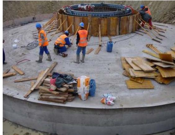
La progettazione e l'installazione delle casseformi terranno conto delle strutture temporanee come le controventature e prenderanno in considerazione i requisiti per la gestione, la regolazione, la legatura, il carico e lo smontaggio. Controventature e casseforme non devono essere rimossi fino a quando il cemento ha guadagnato forza sufficiente come indicato dal progettista delle fondazioni.
