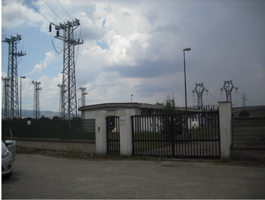
Fig.5 – Cabina in località Monte Piano (Tricarico)
