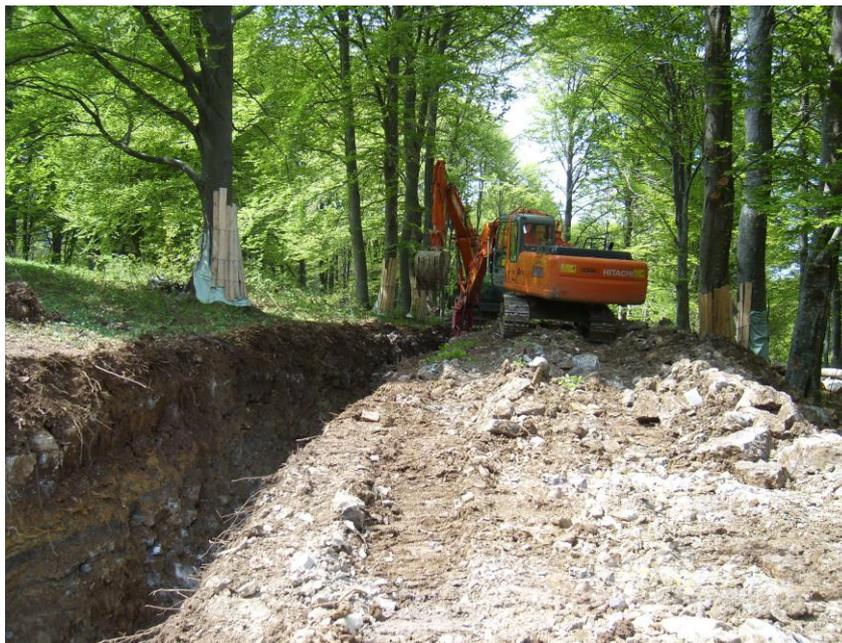
Figura 6 Foto tipica di scavo della trincea
