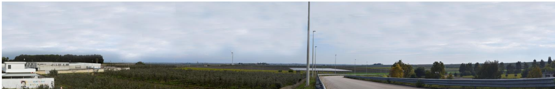
Panoramica – stato dei luoghi ex ante
