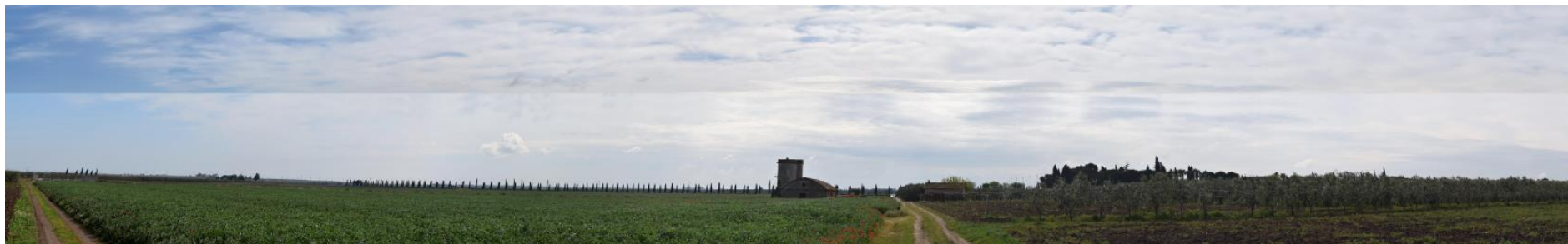
Panoramica – stato dei luoghi ex ante
