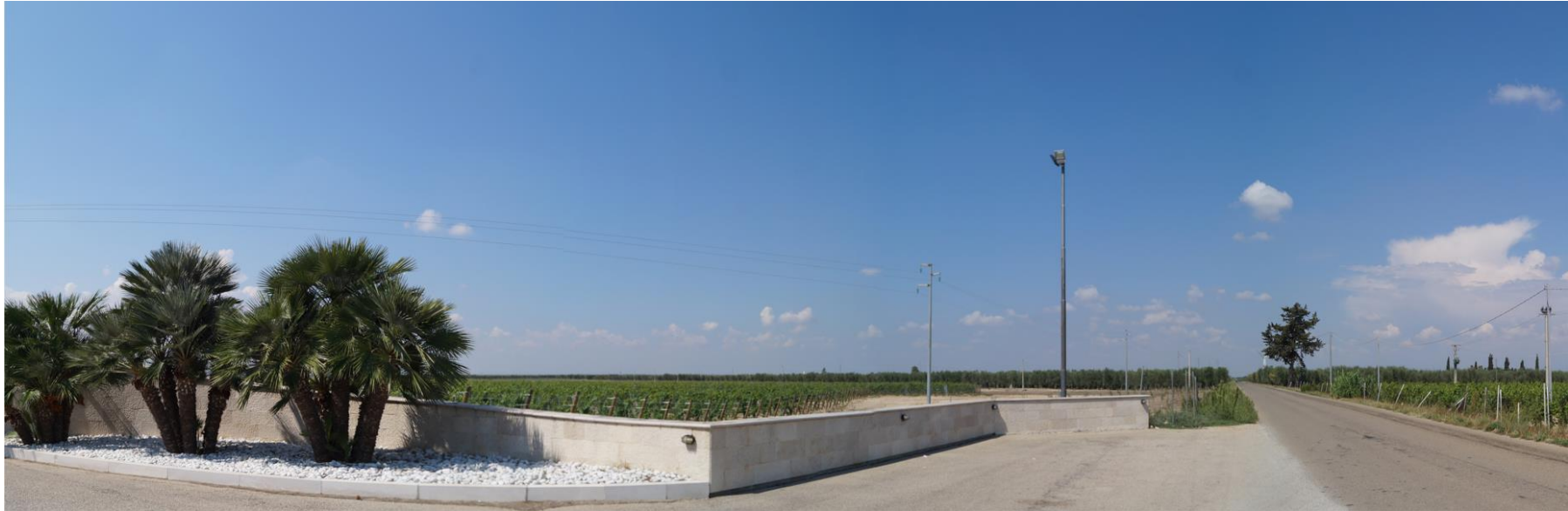
Panoramica – stato dei luoghi ex ante
