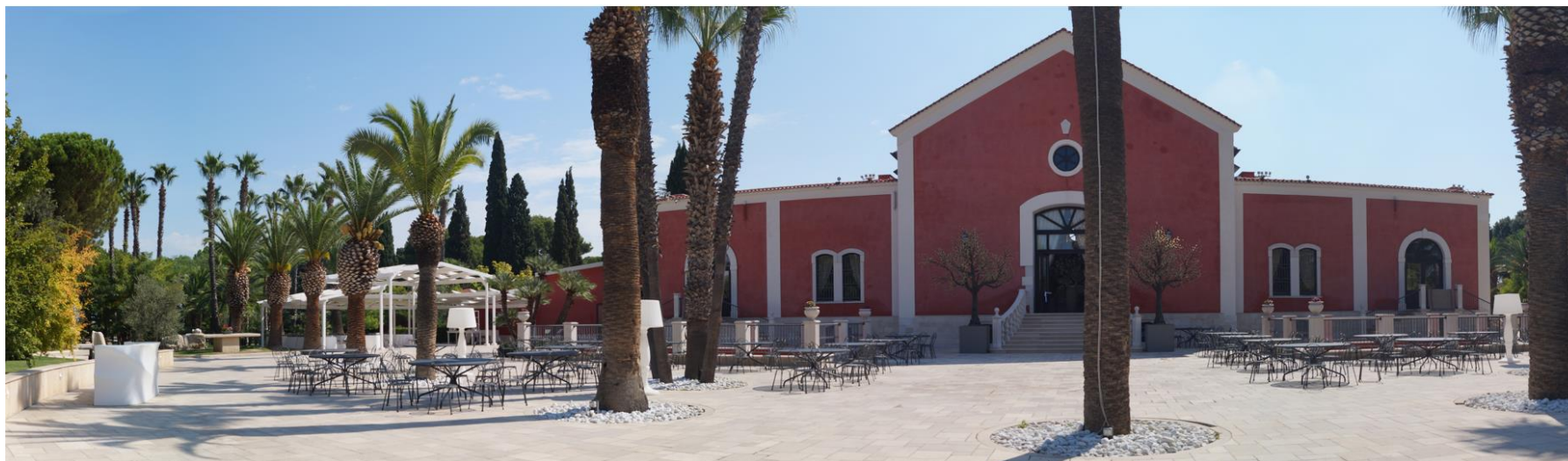
Panoramica – stato dei luoghi ex ante
