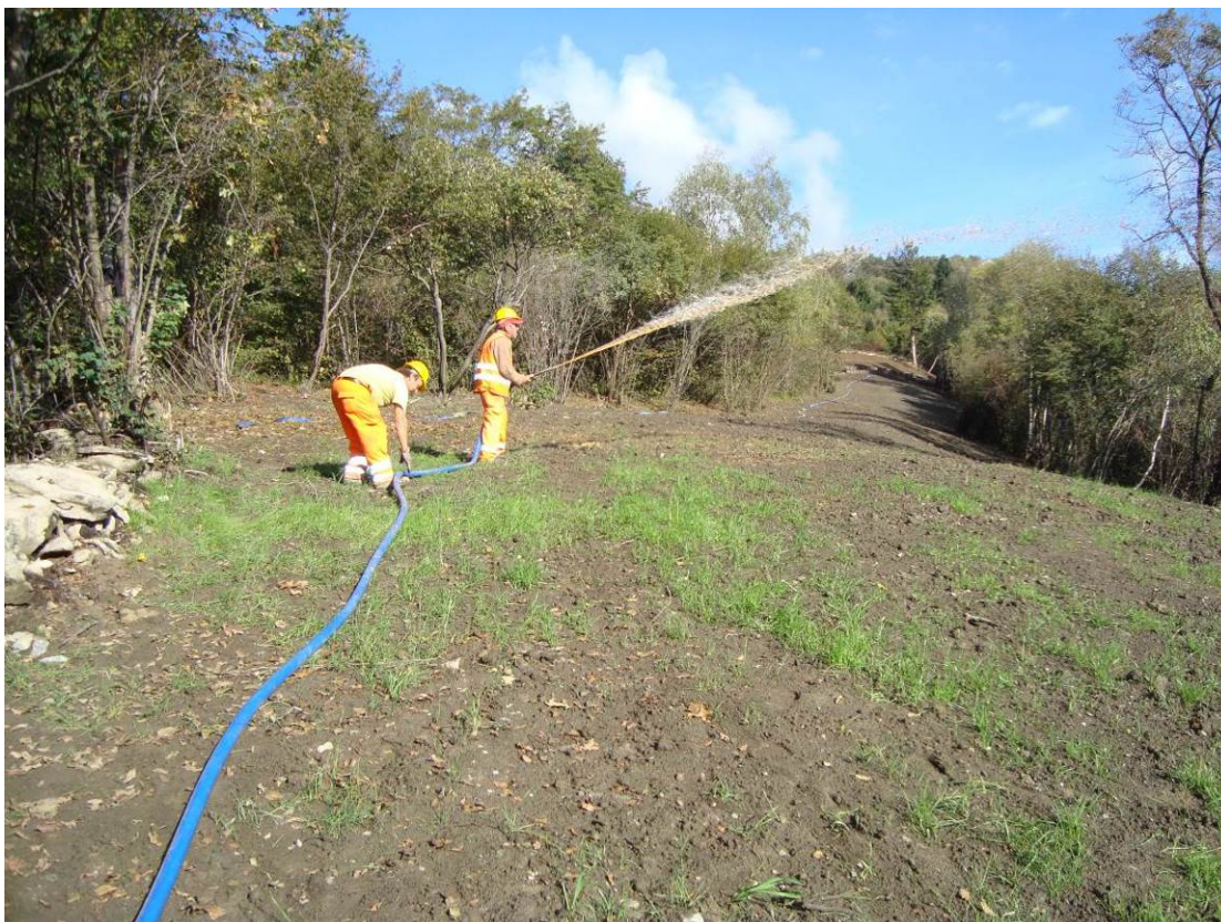
Foto 4.1-A: Distribuzione del miscuglio di semi per l'inerbimento e del quantitativo di fertilizzanti mediante idrosemina.
