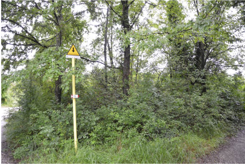
Foto 4.8-D: Variante Creazione Nuovo Stacco per Inserimento BY-PASS DN 400 (16"), DP 64 bar. Boscaglia carsica densa a prevalenza di quercia, bagolaro, malebbo e robinia nei pressi dell'impianto esistente.
