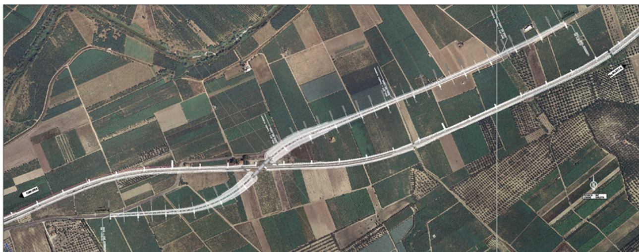
Figura 10 – Cavalcaferrovia NW03 – Inquadramento
