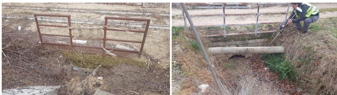
Figura 38 – Opera ferroviaria esistente
