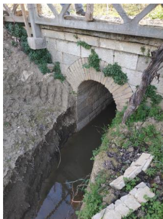
Figura 32 – Opera ferroviaria esistente
