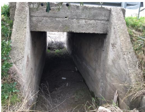
Figura 42 – Opera ferroviaria esistente
