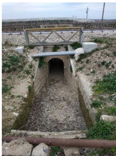
Figura 50 – Opera ferroviaria esistente
