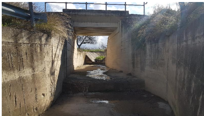
Figura 54 – Opera ferroviaria esistente
