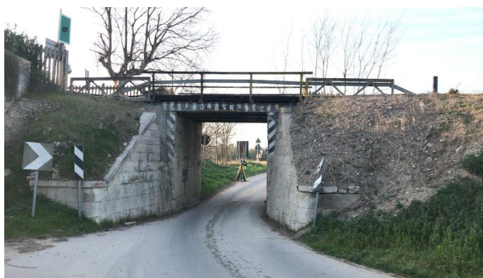
Figura 20 – Opera esistente pk 11+720
