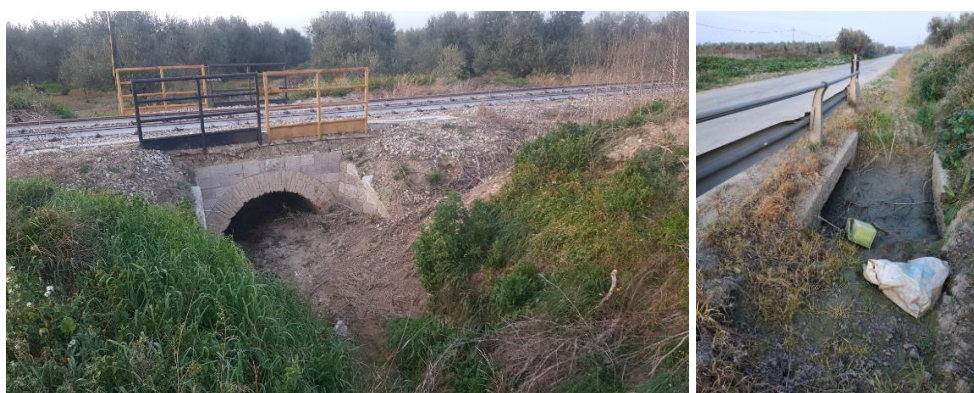
Figura 23 – Attraversamenti esistenti: ferroviario a sx e stradale (SP3) a valle della ferrovia a dx
