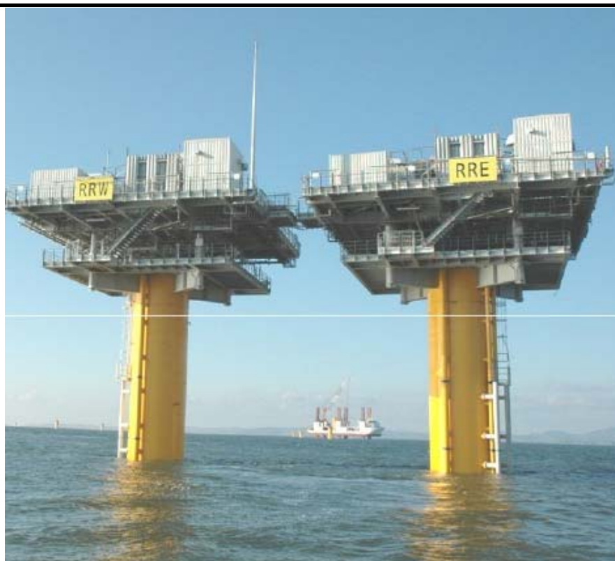
Figura 3.13 Esempio di Sottostazione Elettrica Offshore
