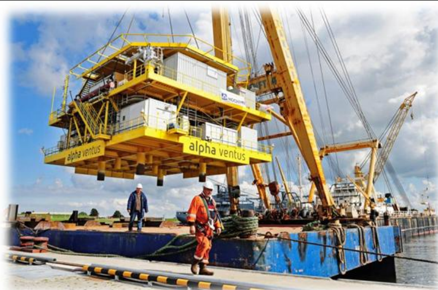
Figura 3.50 Trasporto verso l'Area di Cantiere di una Sottostazione Elettrica Offshore Preassemblata
