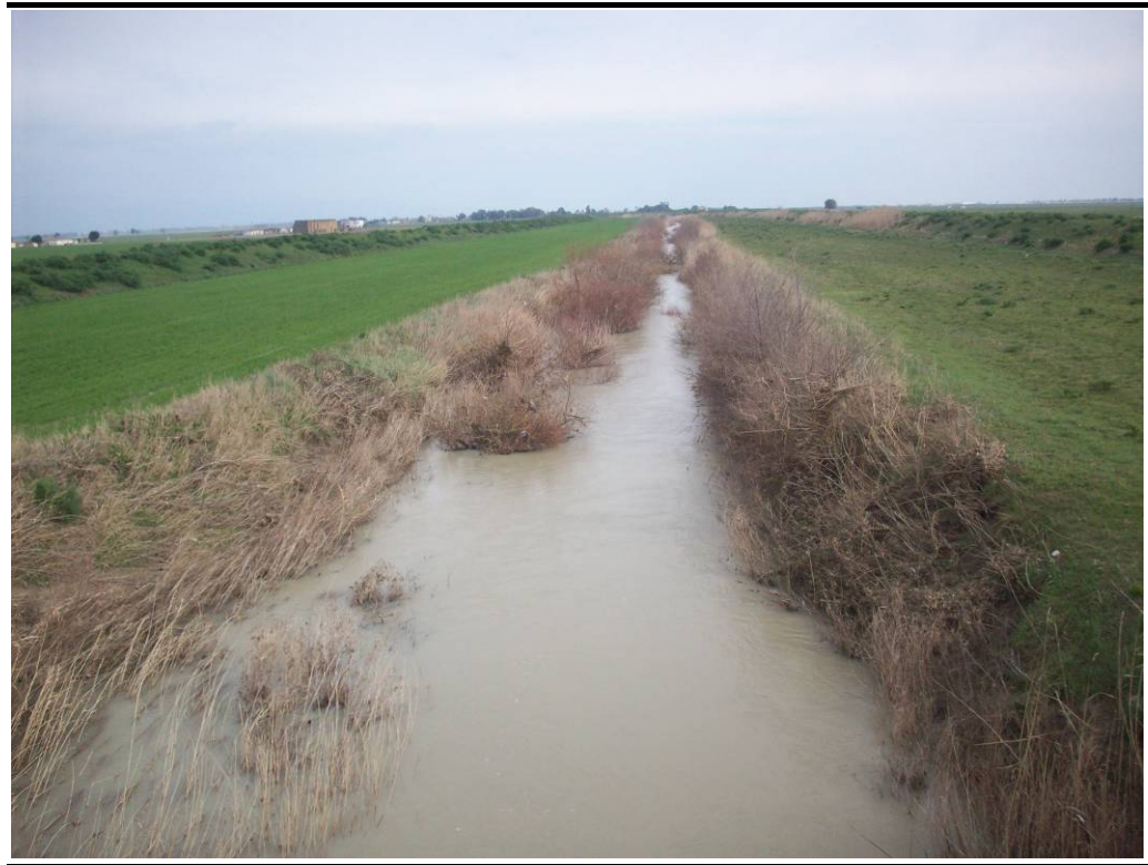
Attraversamento Torrente Cervaro (progressivo km 6,5)
