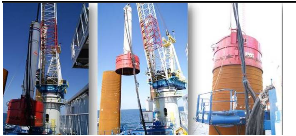
Figura 3.42 Sequenza di Applicazione del Martello (in bianco) e Adattatore
