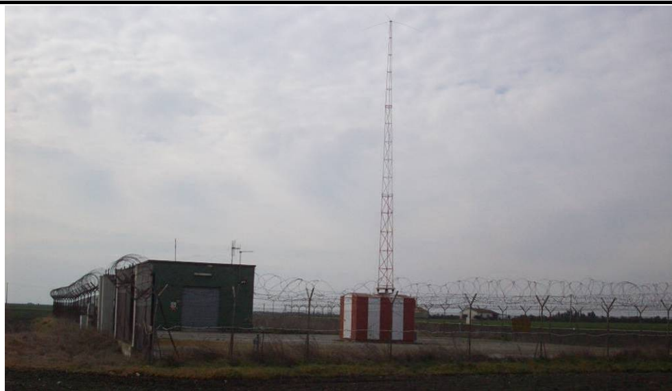
Figura 3.23 Area Militare (progressivo km 7,5)
