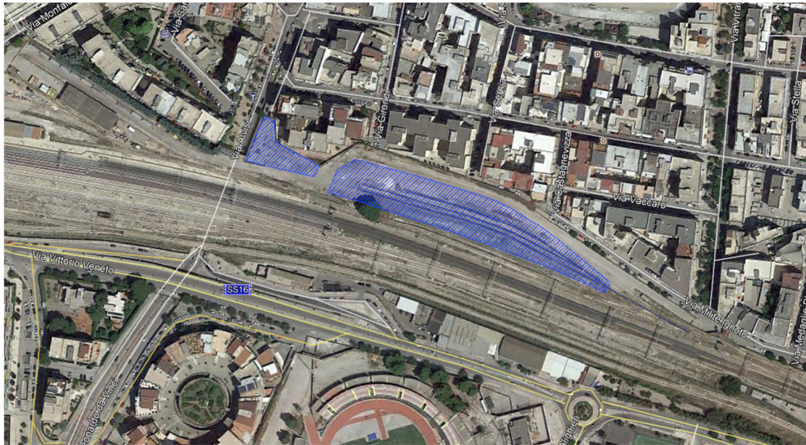
Foto 1 – (vista dell'area di cantiere)
