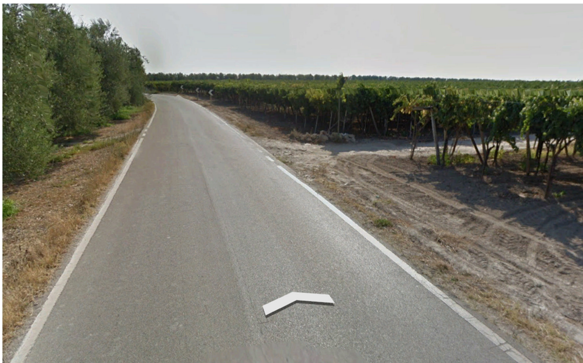
L'accesso al cantiere avviene dalla SS3.
