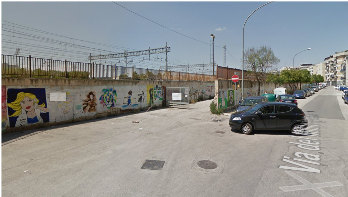
Vista dell'ingresso alla CA.01
