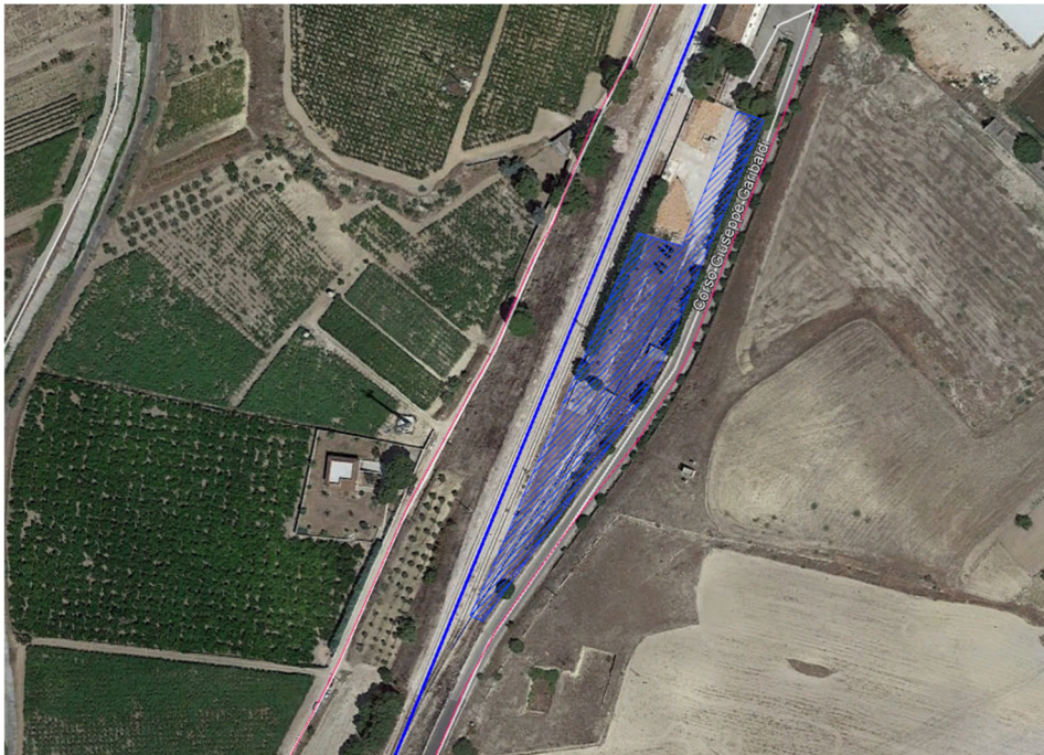
Foto 1 – (vista dell'area di cantiere)
