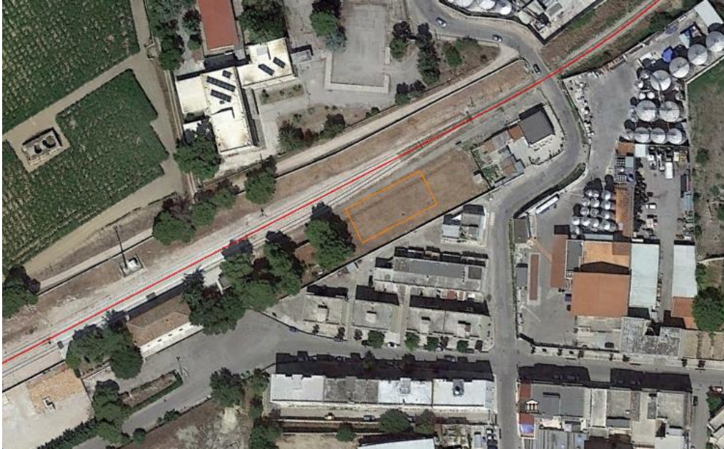
Figura 6-7 Area tecnica AT.42
