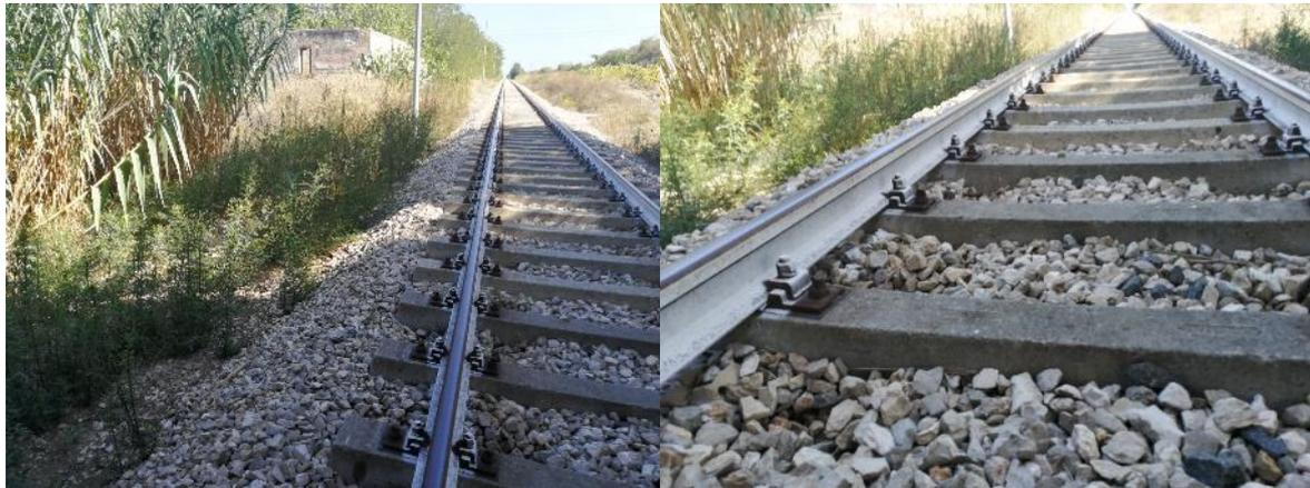
Figura 9-2 Abbassamento del ballast alla 3+740.
