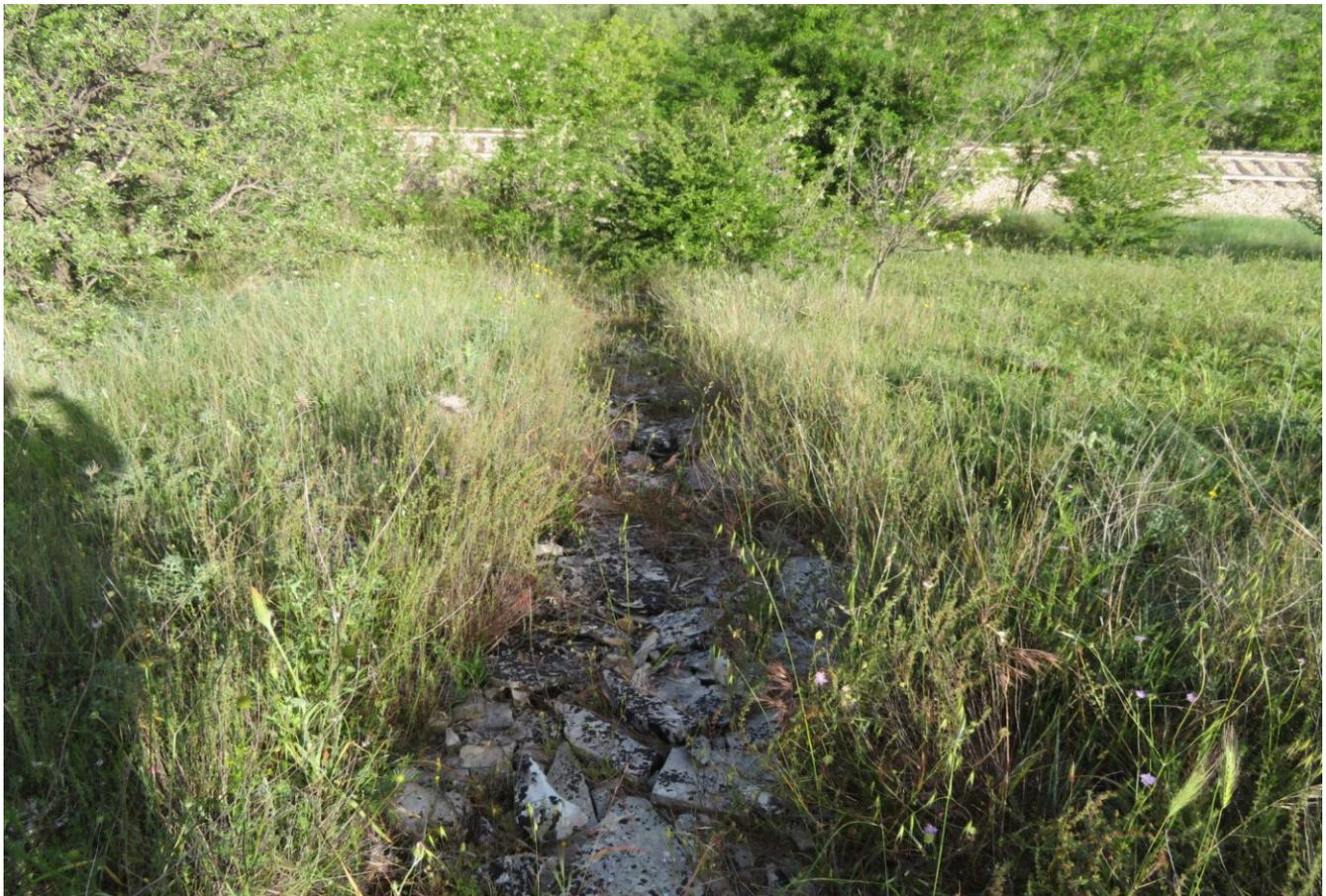
Figura 9-5 Foto in corrispondenza di una delle trincee drenanti realizzate in pietrame calcareo. La foto è stata scattata da sopra il versante verso il basso dove corre la linea ferroviaria.
