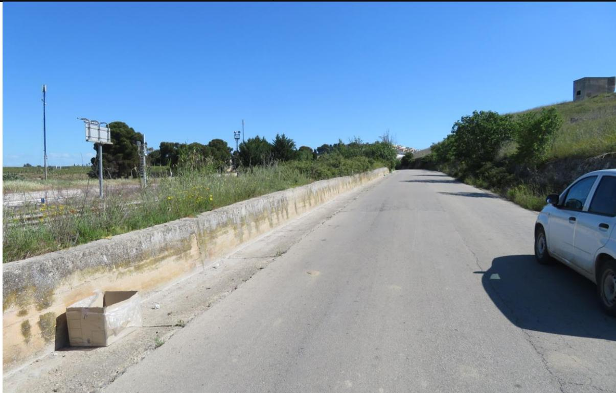
*Figura 10-13.1 Panoramica dell'areale di progetto nel pressi della Stazione di Canosa di Puglia. A destra muro di sostegno sulle calcareniti di Gravina. A sinistra muretto basso per proteggere la ferrovia dalle acque e dai detriti.*
