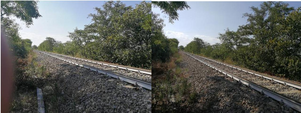
Figura 9-3 Foto scattate alla pk 10+300 dove si registra l'abbassamento del ballast.
