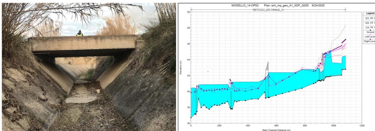
*Figura 57 – Opera ferroviaria esistente e profilo stato di fatto Tr 200*
