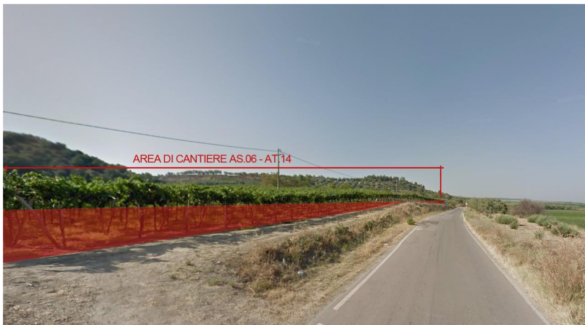
Figura 7-5 - Individuazione sommaria delle aree dei cantieri AS.06 e AT.14 dalla SP3 in direzione ovest
