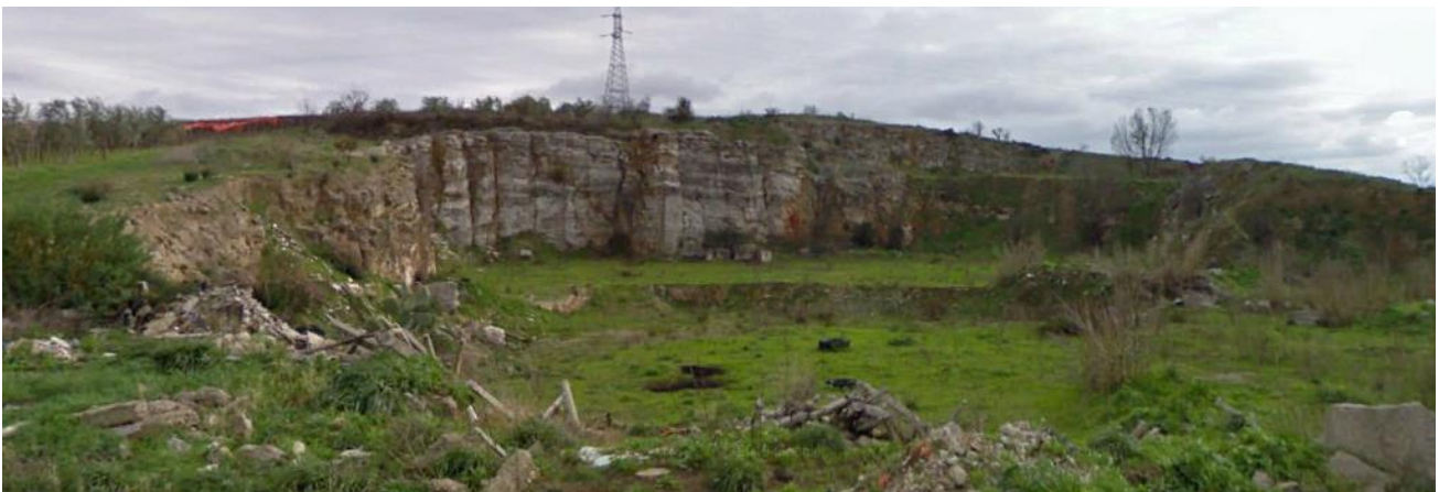
Figura 5-10 Veduta frontale dell'affioramento: Si possono osservare vari altezze (livelli) del piano campagna dovuti ad attività di scavo: In primo piano materiali di scarto abbandonati
