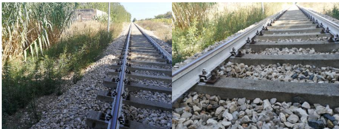
Figura 9-2 Abbassamento del ballast alla 3+740.
