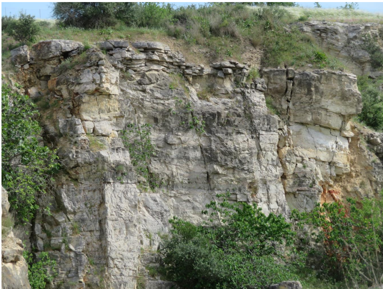
Figura 10-7. Particolare del fronte di scavo. I calcari appaiono compatti disposti in strati suborizzontali da centimetrici a decimetrici.
