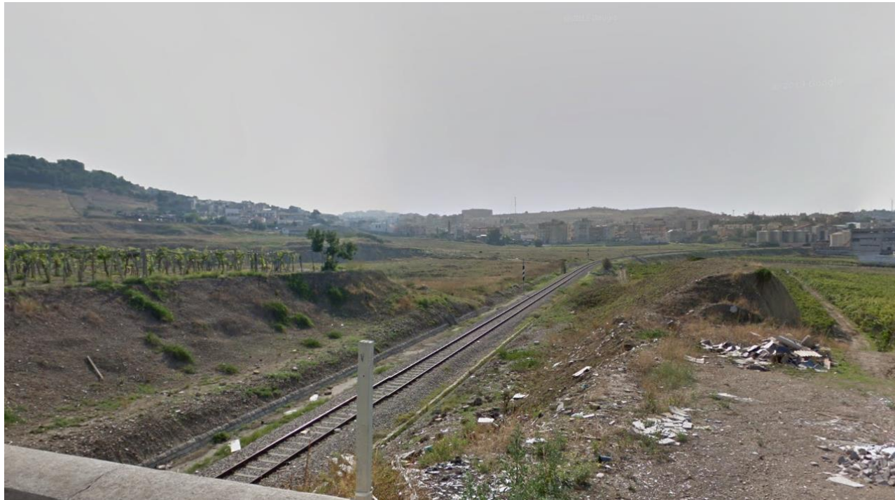
FIGURA 13 AREE MARGINALI, SOTTOUTILIZZATE NEL TRATTO DI APPROCCIO ALL'ABITATO DI CANOSA
