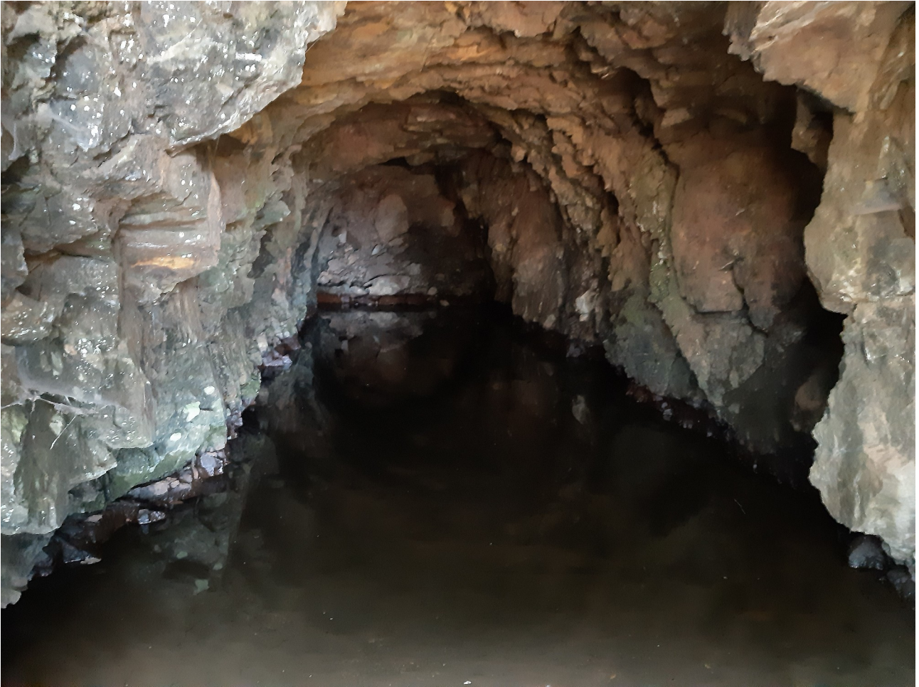
foto 8, esempio di galleria minore impraticabile in quanto totalmente allagata in questo caso a causa di una frana che impedisce il deflusso idrico, altre son chiuse per motivi di sicurezza
