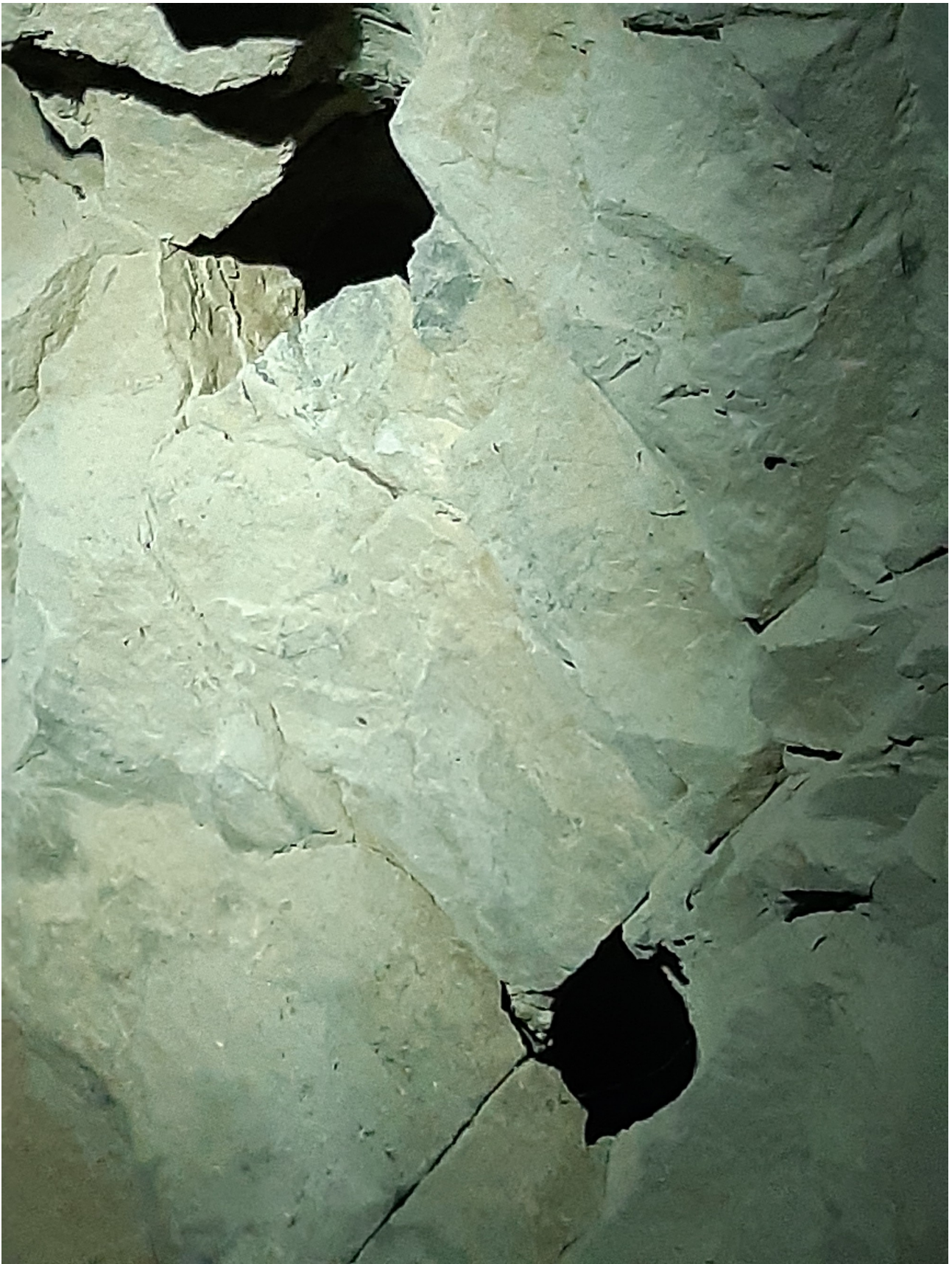
foto 3 volta della galleria 20 con vista fori di volata non occupati
