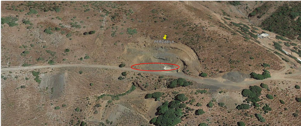
Area ubicazione Impianto di trattamento
